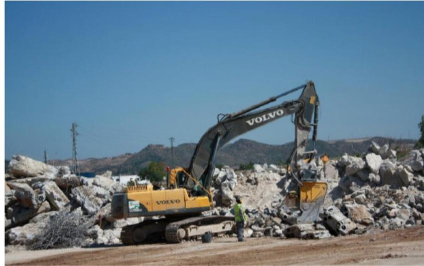
**Figura 29.** Pre-acondicionamiento de los residuos
