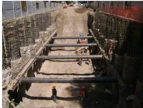
**Figura 5.** Fabricación de pilotes y relleno de zapatas con material reciclado
