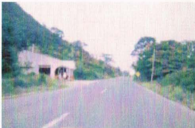
Ilustración 38- Carretera Huejutla - Tamazunchale (S.L.P.)
