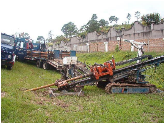
Realizando perforaciones horizontales
