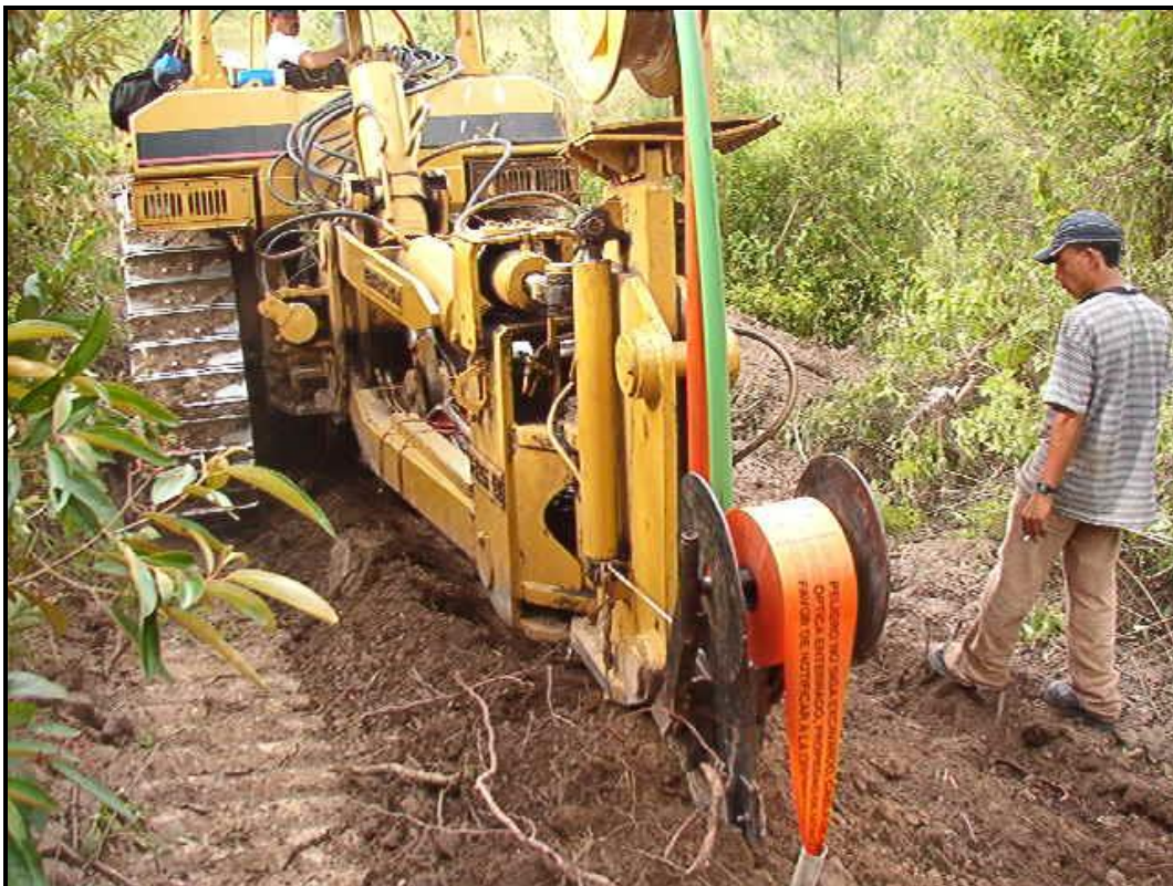
FOTOGRAFÍA 50 “TENEDORA DE TUBERIA CON ADITAMENTO PARA COLOCAR SEÑALAMIENTO”
