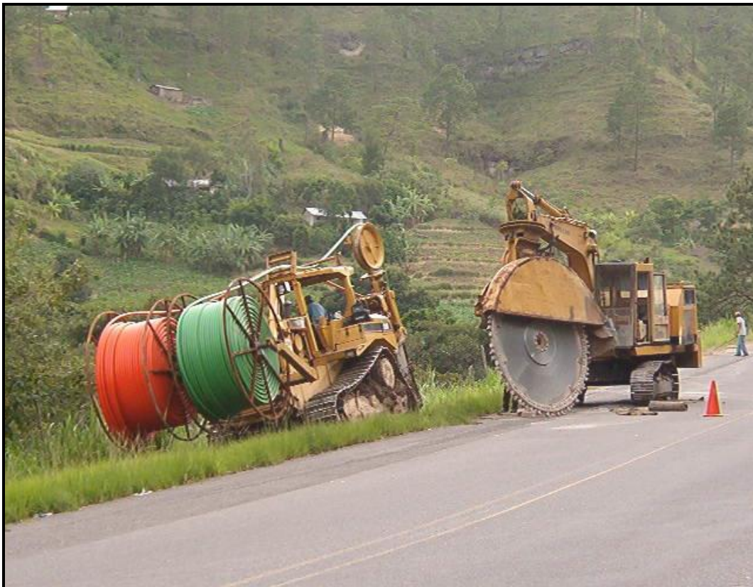
FOTOGRAFÍA 51 “TENEDORA DE CABLE DE FIBRA ÓPTICA Y PETRATERRA”
