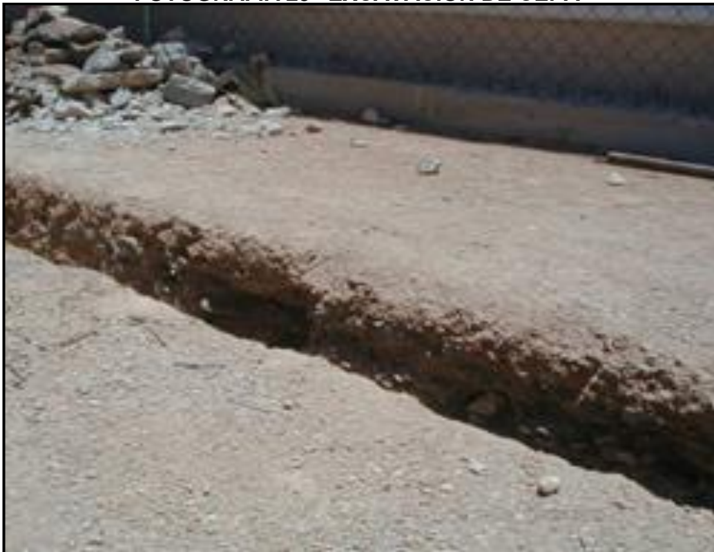
FOTOGRAFÍA 29 “EXCAVACIÓN DE CEPA”
