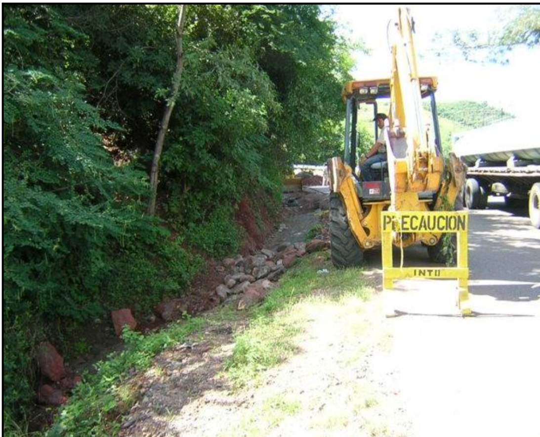
FOTOGRAFÍA 24 “EXCAVACIÓN CON RETROEXCAVADORA”
