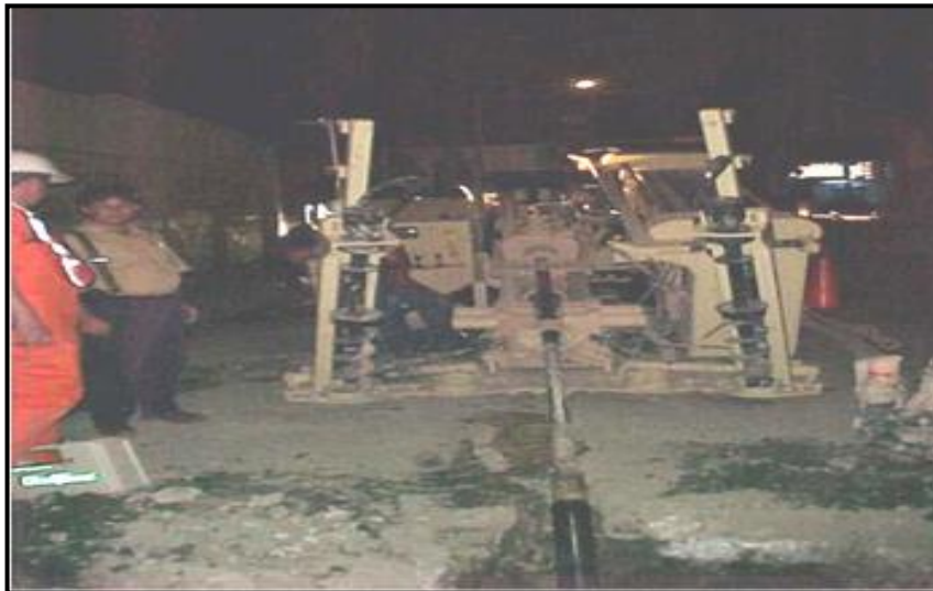
FOTOGRAFÍA 10 “PERFORACIÓN DIRECCIONAL”
