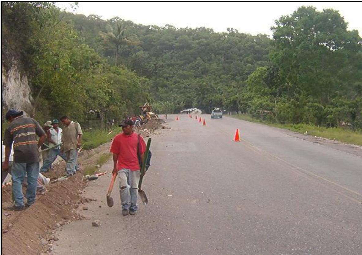
FOTOGRAFÍA 46 “MANO DE OBRA UTILIZADA PARA ZANJEAR”
