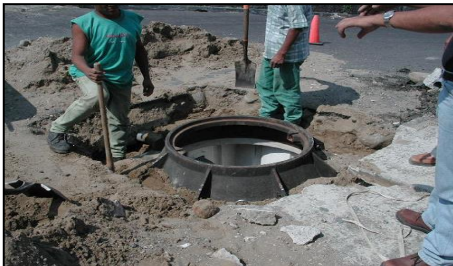
FOTOGRAFÍA 13 “COLOCACIÓN DE CÁMARA MANHOLE”
