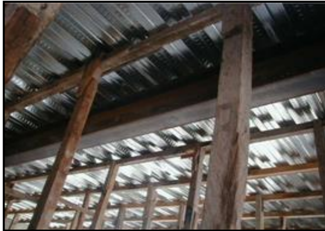
FOTOGRAFÍA 30 “CIMBRA EN LOSACERO”
