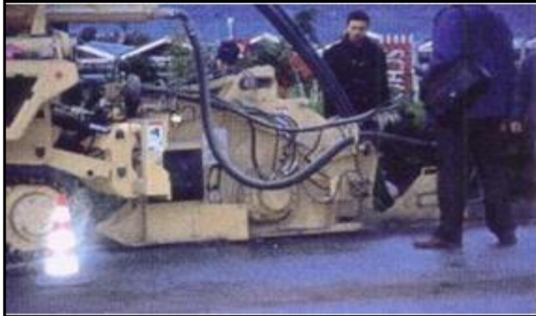
FOTOGRAFÍA 19 “LUCES DE SEGURIDAD”
