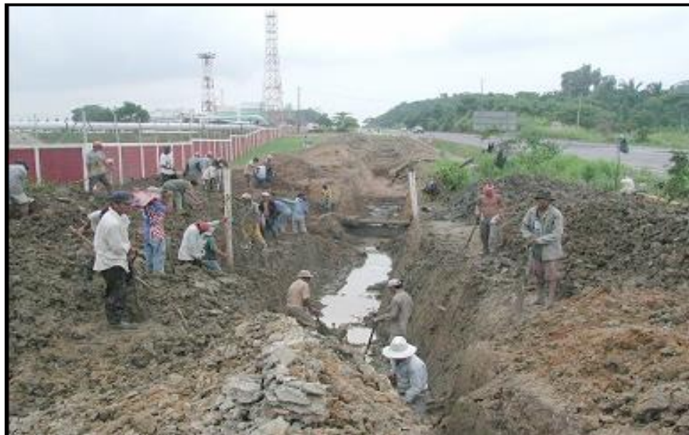
FOTOGRAFÍA 6 “EXCAVACIÓN A MANO EN DERECHO DE VÍA”
