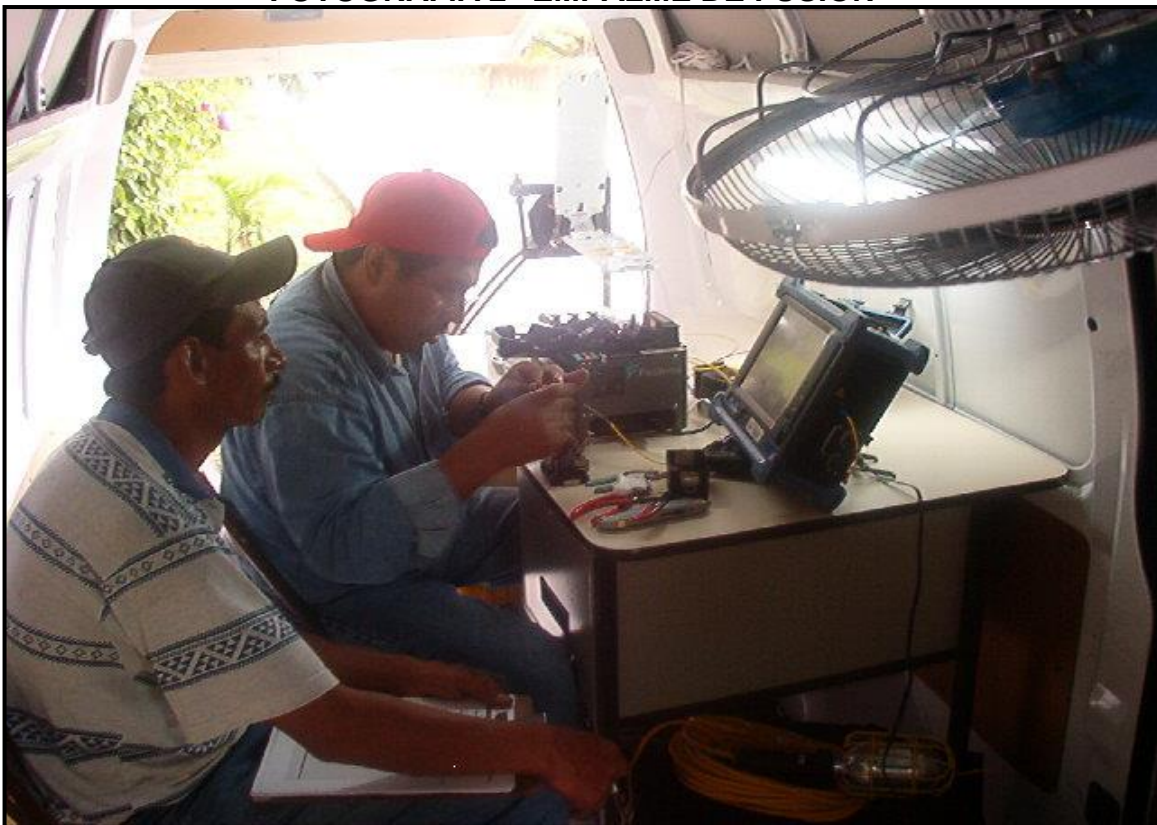
FOTOGRAFÍA 2 “EMPALME DE FUSIÓN”
