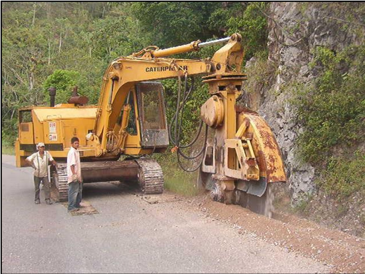
FOTOGRAFÍA 48 “CORTADORA DE DISCO PARA HACER ZANJA”
