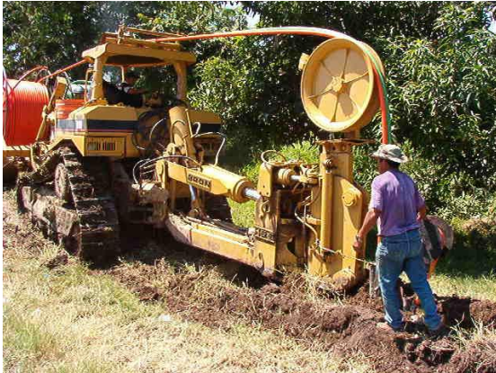
Inmersión de ducto con Arado
