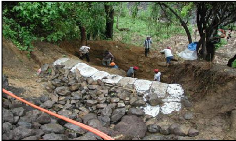
FOTOGRAFÍA 12 “CONTROL DE EROSIÓN MEDIANTE GAVIONES”
