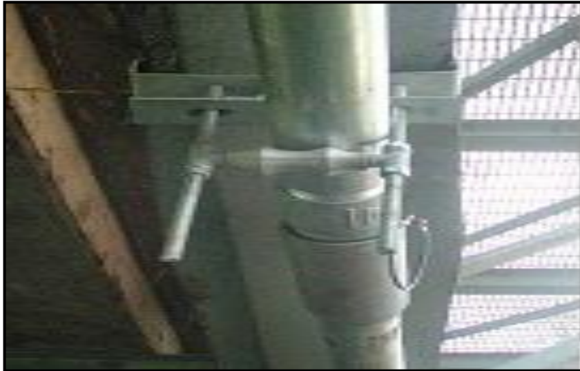
FOTOGRAFÍA 9 “JUNTA DE EXPANSIÓN Y HERRAJE DE COLUMPIO”
