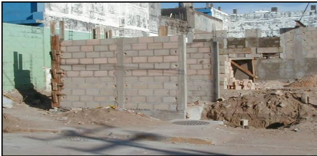
FOTOGRAFÍA 31 “MURO DE LADRILLO CUATROPEADO”
