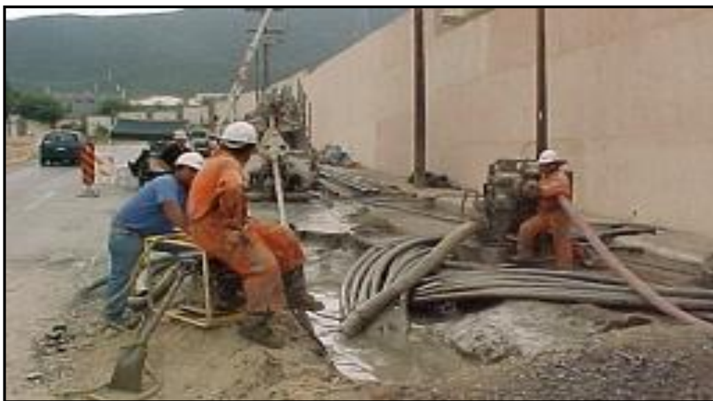
FOTOGRAFÍA 11 “RECUBRIMIENTO DE TUBO HDPE”
