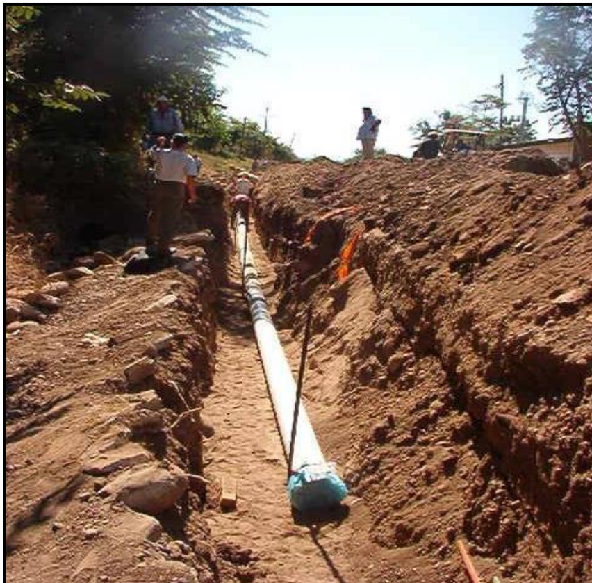
FOTOGRAFÍA 25 “COLOCACIÓN DE TUBO DE PVC”
