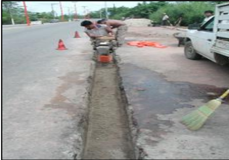
FOTOGRAFÍA 7 “COMPACTACIÓN EN ZONA URBANA”
