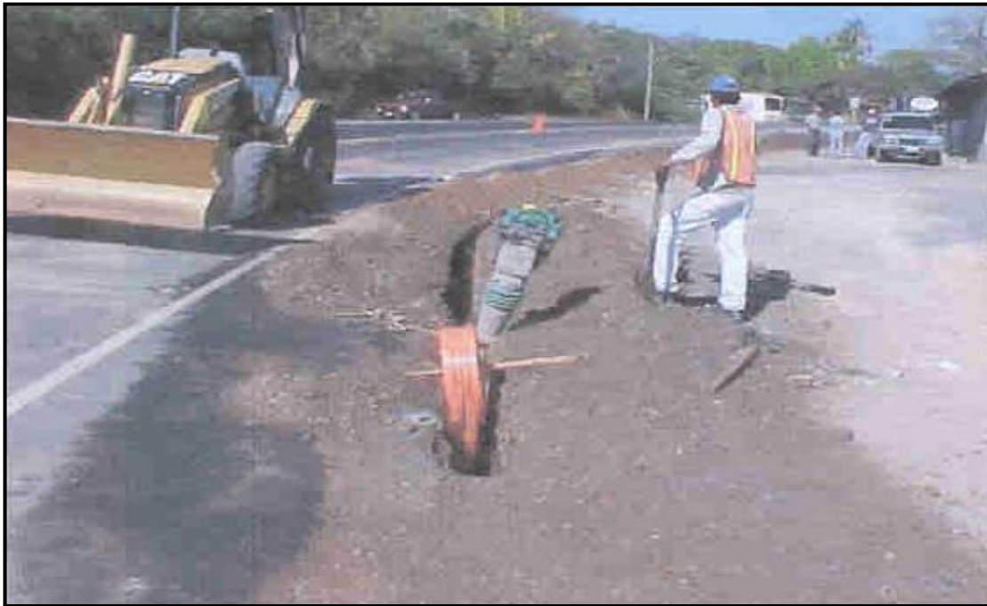
FOTOGRAFÍA 17 “COLOCACIÓN DE CINTA DE PRECAUCIÓN”
