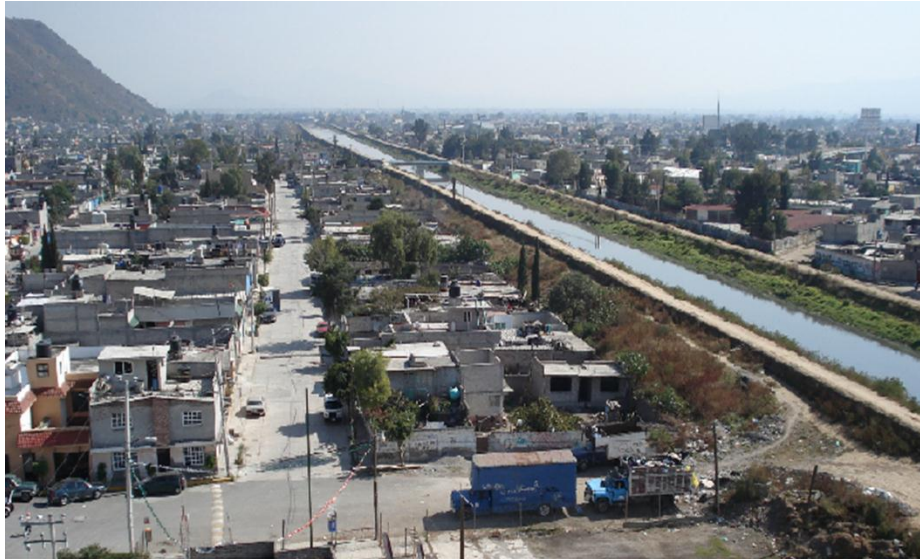
Ilustración 1: Canal a cielo abierto “Río de la Compañía”
