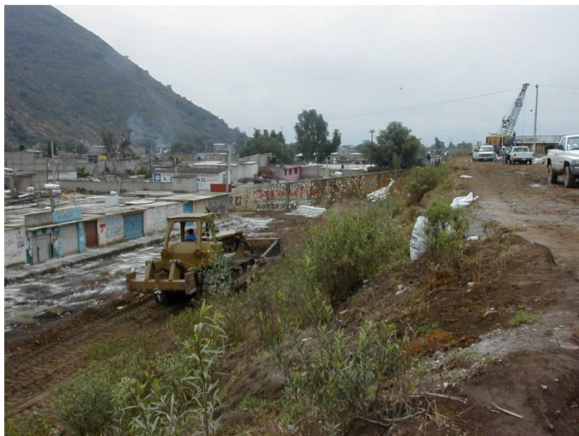
Ilustración 7: Sobreelevación y reparación de los bordos
