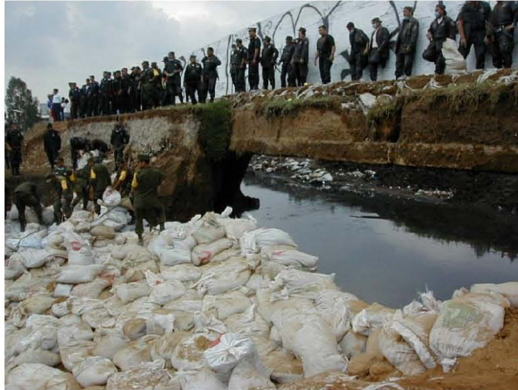
Ilustración 4: Costalera para reparación de bordo
