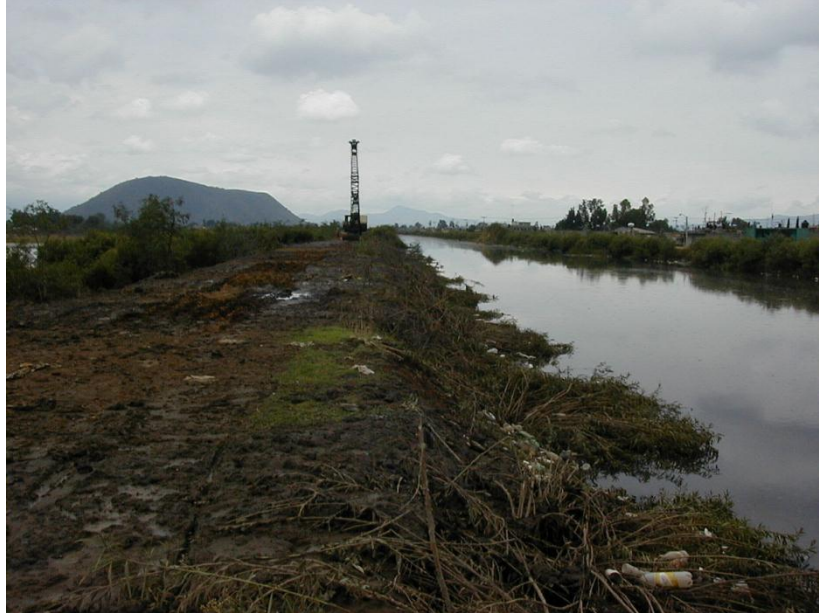
Ilustración 6: Desazolve del río
