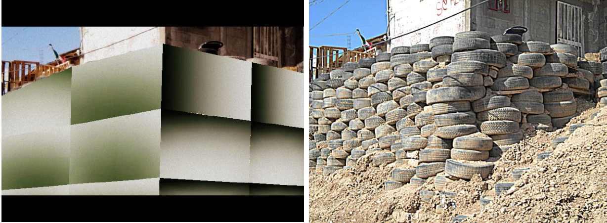
Imagen número 13. Frente a la carencia de recursos, la racionalidad propia del poblador popular resuelve construir un muro de contención con llantas en lugar de concreto o mampostería. Imagen de diseño y fotografía propios.
