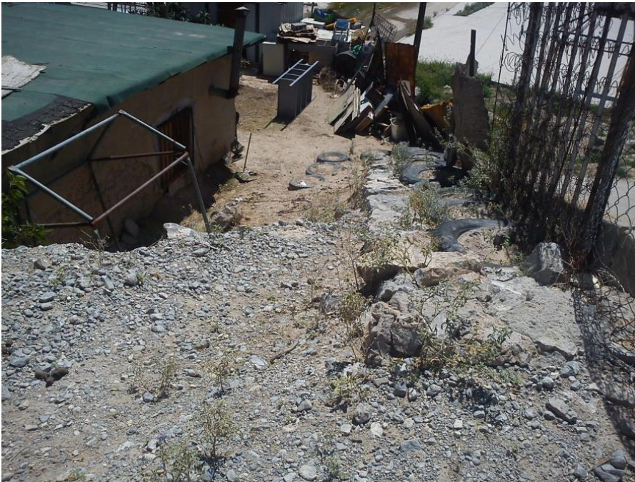
Imagen número 42. En la fotografía se muestra la topografía accidentada del predio, el tipo rocoso de suelo, la escalera hecha a base de llantas recicladas que funcionan como peldaños y en conjunto como muro estabilizador en colindancia. Fotografía de Gabriela Nava.
