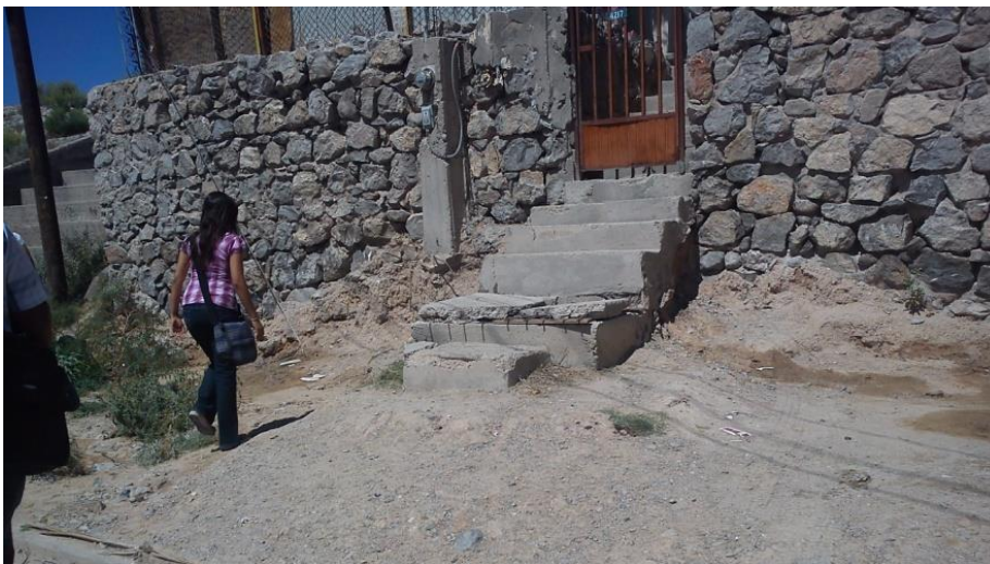
Imagen número 41. En esta fotografía se muestra la vivienda con su muro de acceso elaborado con piedra y el cambio de nivel de piso entre el exterior y el interior del predio. Fotografía de Gabriela Nava.
