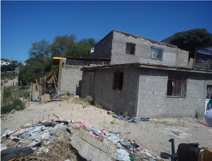
Imagen número 43. En la fotografía se muestra la casa de un solo nivel y sus colindantes de dos niveles, se puede además apreciar que las paredes son de bloque y el techo de madera, así mismo, se identifica la puerta de acceso. Fotografía de Gabriela Nava.
