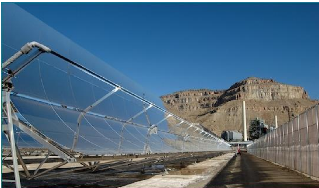
Figura 3.5 Arreglo cilindro parabólico. Palisades, Colorado (NREL)
