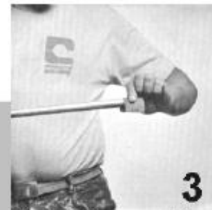
Fig. 2.13. Limpieza exterior del tubo e interior de la conexión
