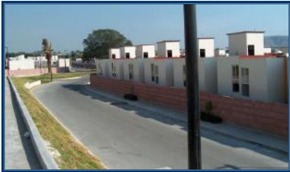
Fachada de una de las unidades habitacionales con materiales que se utilizaran en el Proyecto de Av. Toluca
