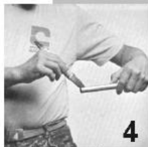
Fig. 2.14. Aplicación de pasta fundente
