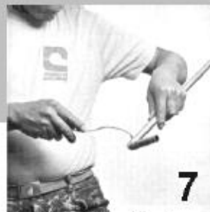
Fig. 2.17. Aplicación de soldadura
