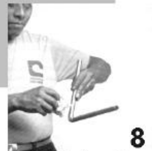
Fig. 2.18. Limpieza de la unión
