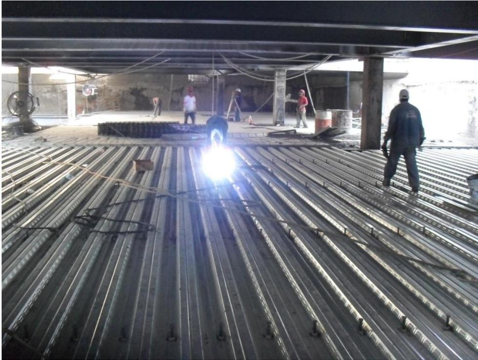
Fotografía 35.- Detalle losacero con pernos Nelson
