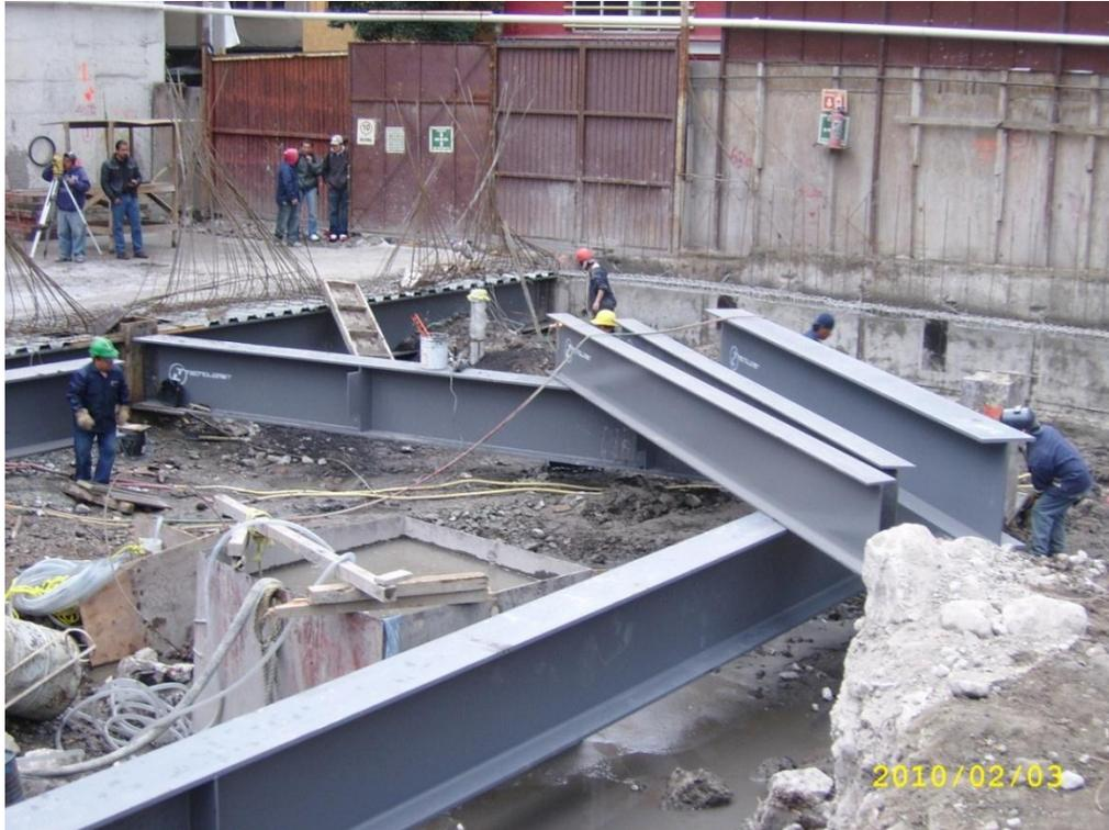
Fotografía 19.- Montaje estructura metálica en planta baja.
