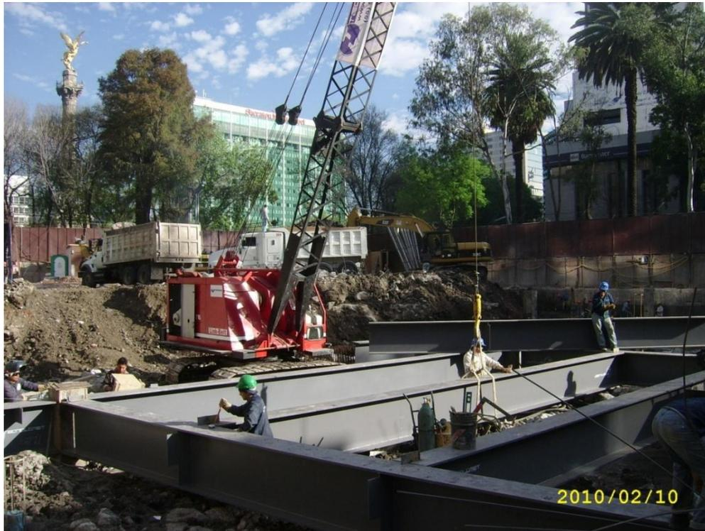
Fotografía 21.- Montaje estructura metálica en planta baja
