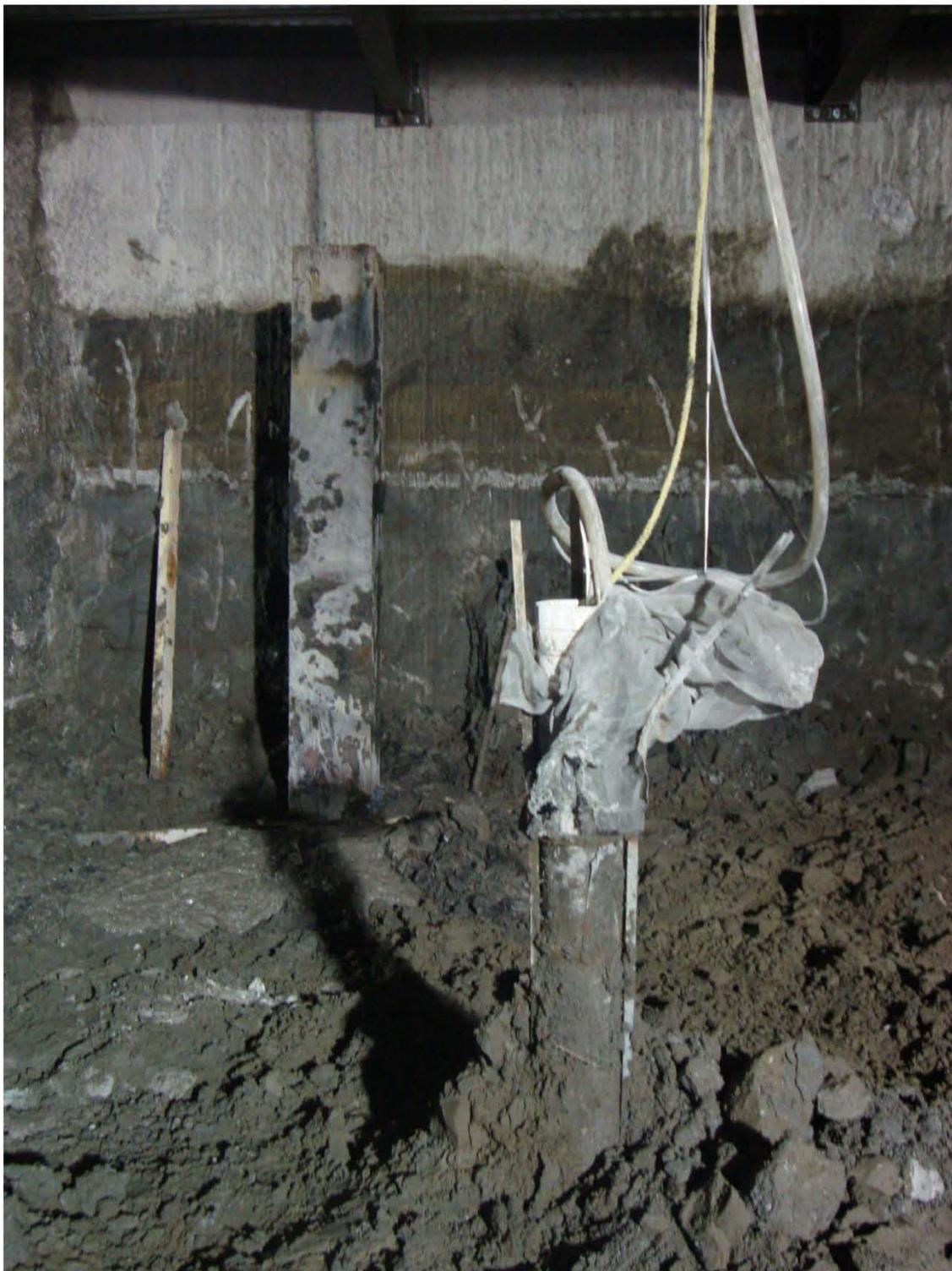
Fotografía 53.- Detalle de pozo de abatimiento, ademe, manguera
