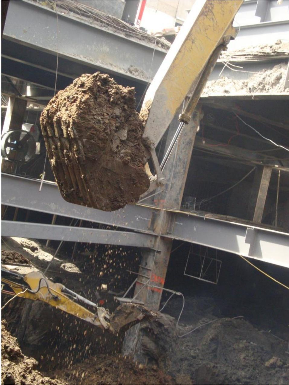
Fotografía 41.- Retroexcavadora rezagando a camión.
