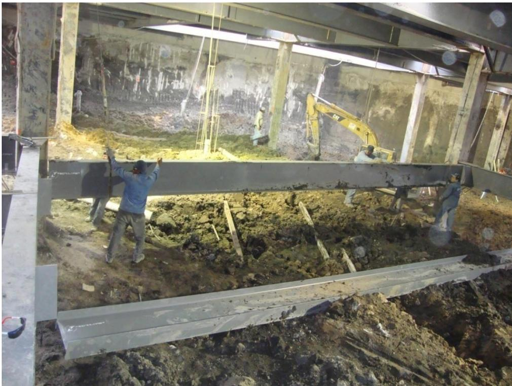
Fotografía 24.- Montaje estructura metálica con tirfo en sótano 1
