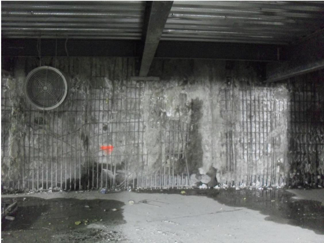
Fotografía 57.- Acero de refuerzo expuesto muro Milán.
