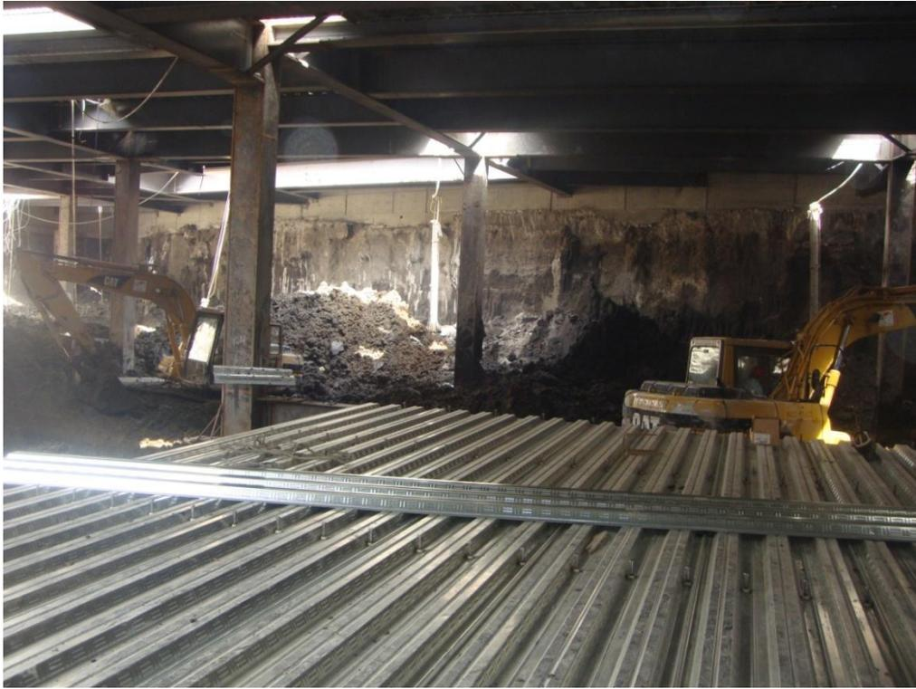
Fotografía 37.- Losacero y excavación
