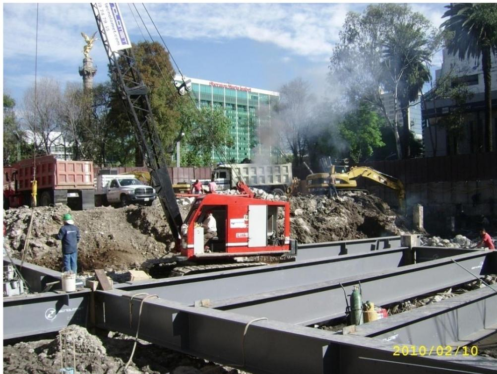
Fotografía 22.- Montaje estructura metálica en planta baja
