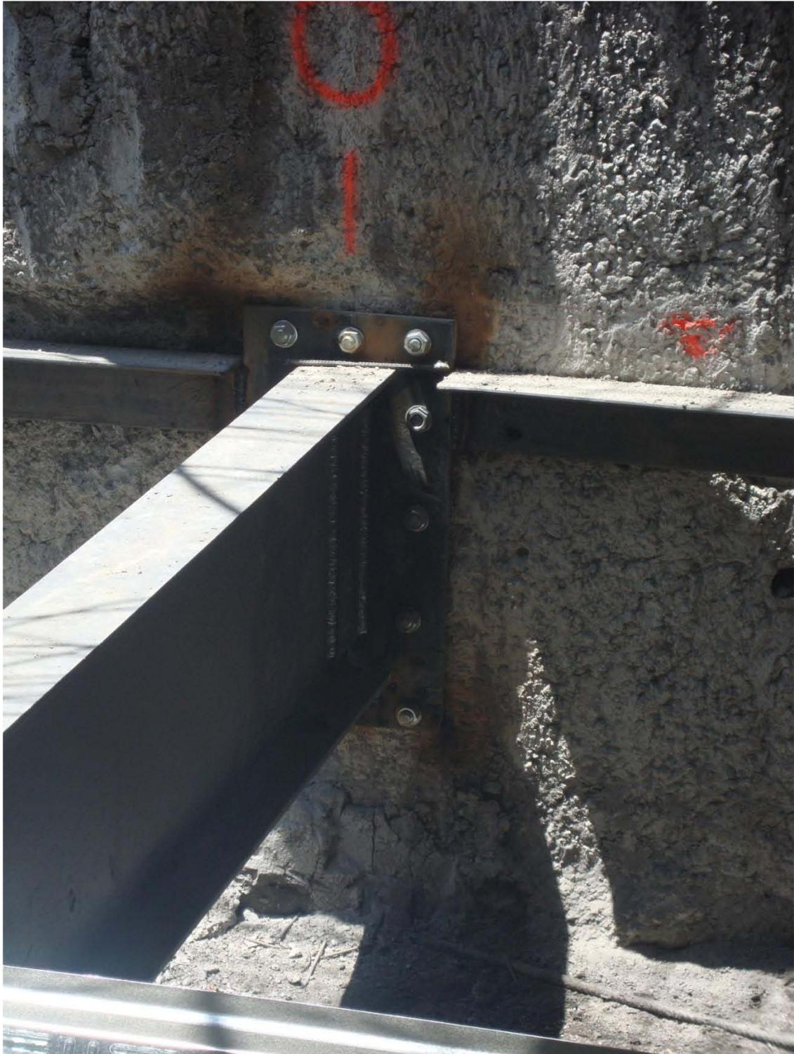
Fotografía 27.- Conexión a muro Milán y ángulo losacero
