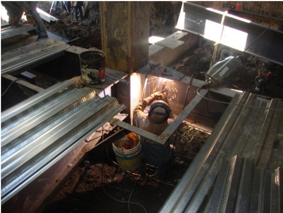
Fotografía 26.- Soldadura en conexiones
