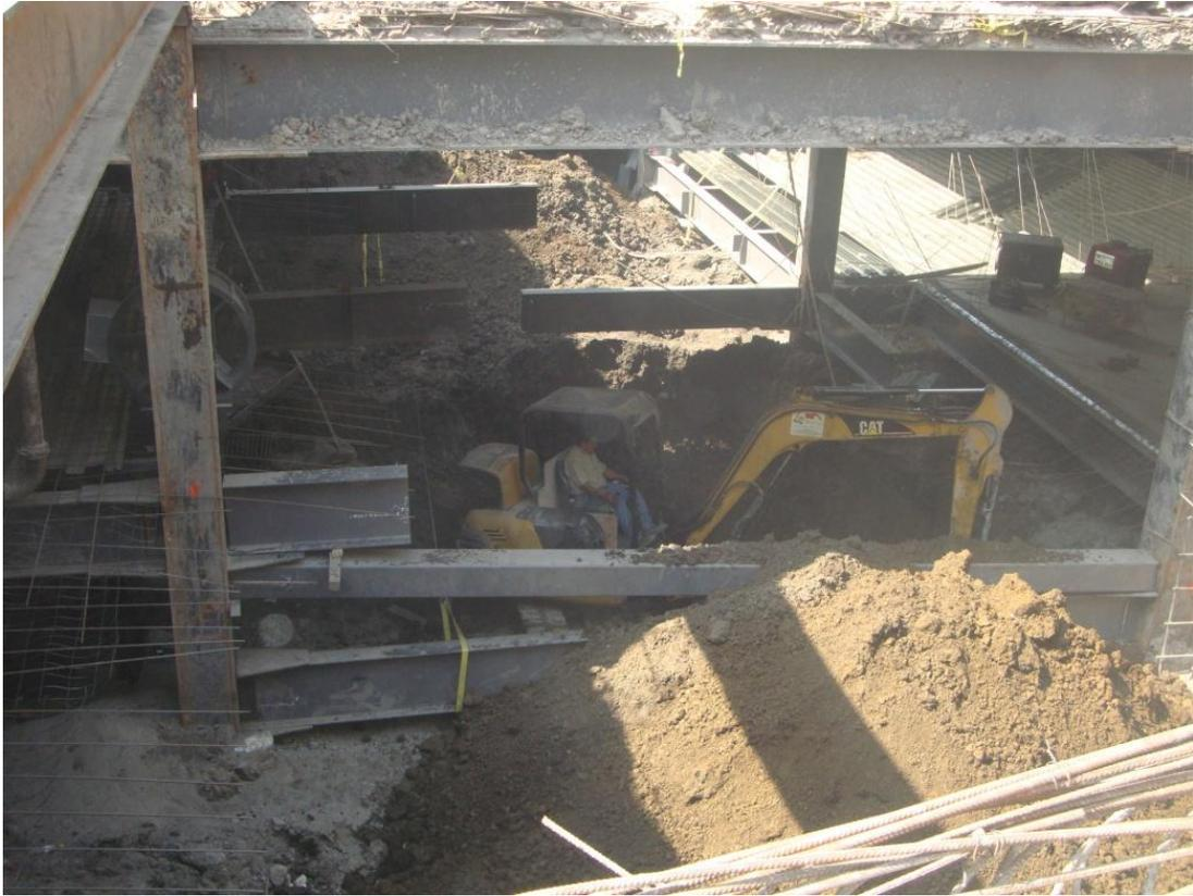
Fotografía 40.- Mini excavadora traspaleando a lumbrera
