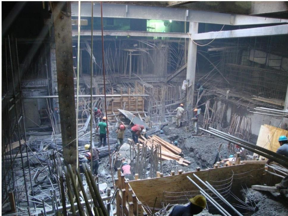
Fotografía 51.- Trabajos en losa de fondo
