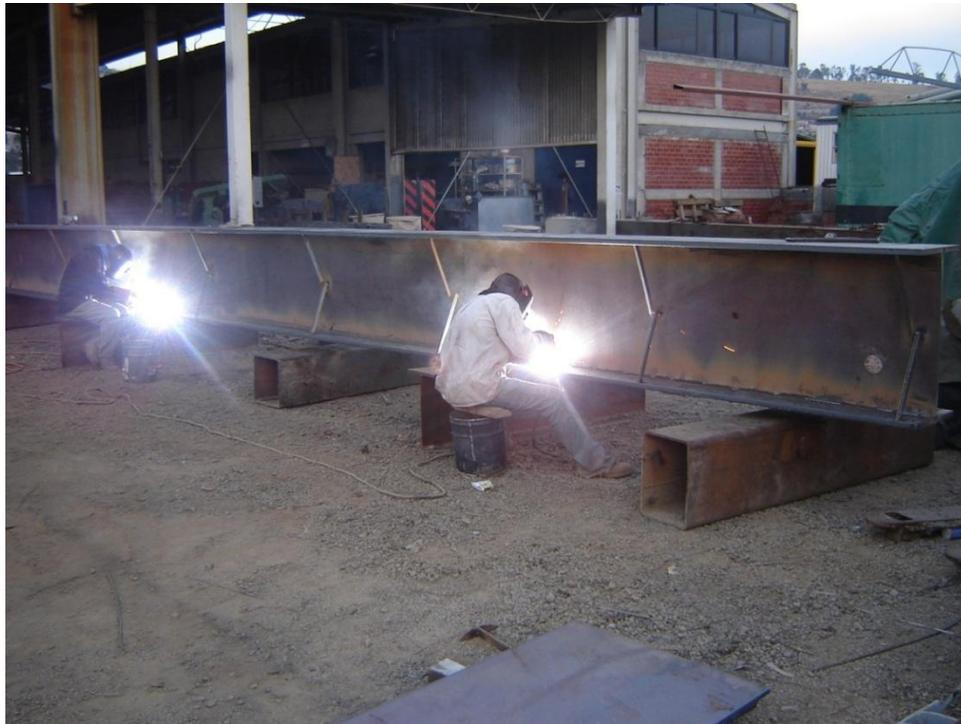
Fotografía 15.- Armado y soldado de la columna.
