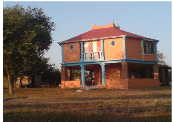
Figura 4. 9.- Vista de la casa a estudio.
