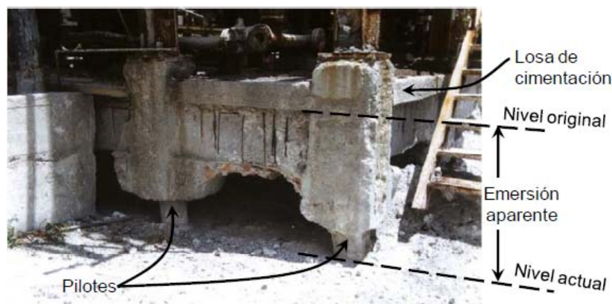
Figura 1.15 Emersión aparente de un grupo de pilotes de punta en el lago de Texcoco (Rodríguez, 2010)
