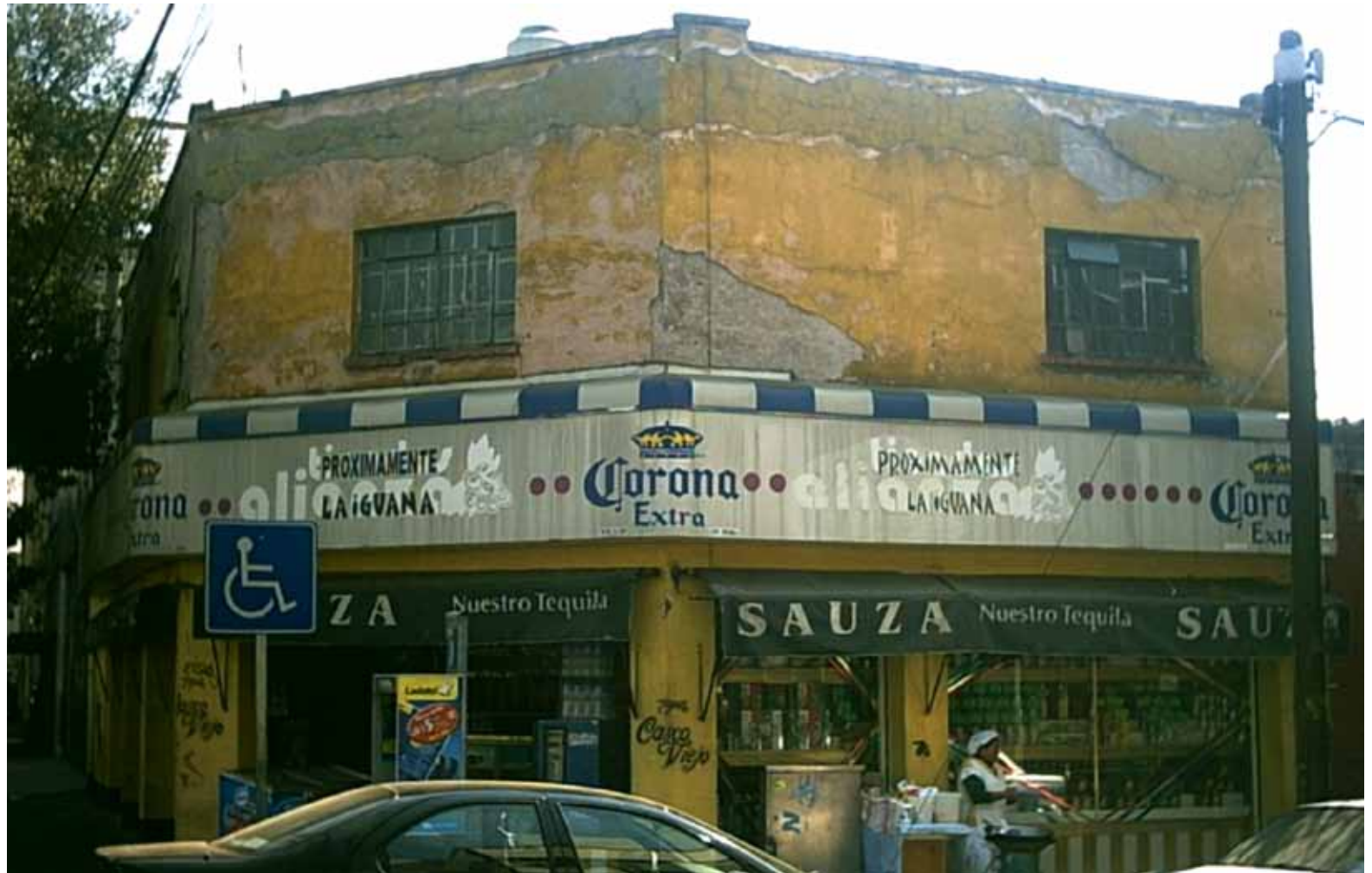
Fachada, vinatera de la cadena Bodegas Alianza a remodelar.
