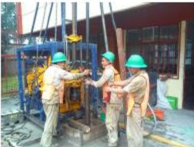
Fotografía N° 03 Maniobras correspondientes al sondeo SM-01
