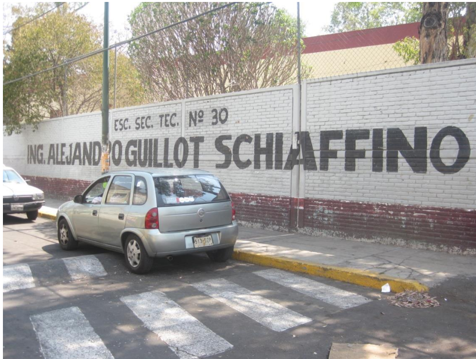
Fotografía 2.1.1 Escuela Secundaria Técnica # 30
