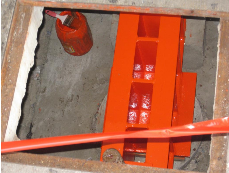
Fotografía 2.4.2 Acceso a cimentación
