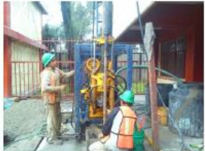
Fotografía N° 02 Acercamiento de los trabajos del SM-01
