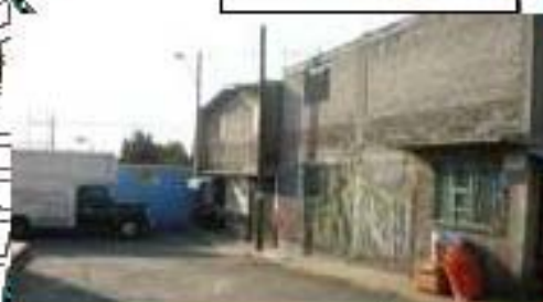
Foto 3. La falta de planeación genero callejones y cerradas.
