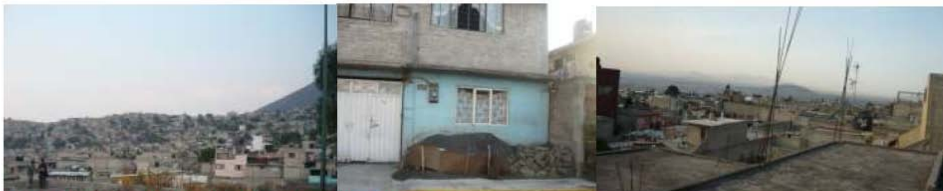
Estado actual de la vivienda en la Colonia Tenorios en Iztapalapa. Galería propia.
