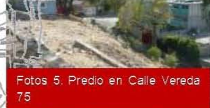
Fotos 5. Predio en Calle Vereda 75
