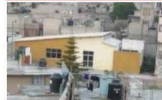
Foto 2. Salón de usos Múltiples
