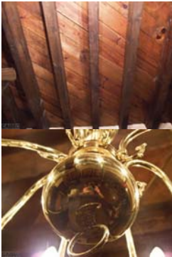
Foto 13 & 14. Detalles arquitectónicos "La Luz".
