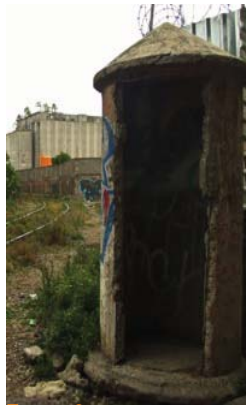
Foto 8. Estructuras en espera de un uso.
