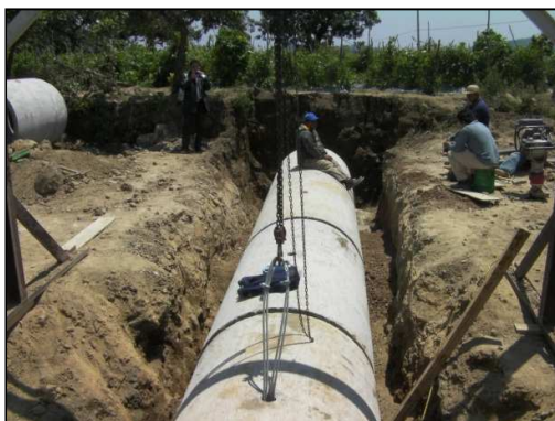
Foto 5.- En esta imagen se muestra la construcción de una de las alcantarillas.
