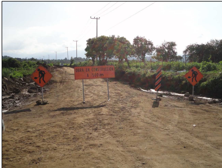
Foto 11.- Vista frontal de los dispositivos de seguridad utilizados durante el desarrollo de la obra.
