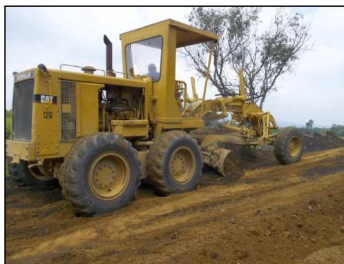
Foto 15.- Motoconformadora Caterpillar Mod. 128 utilizada para tendido y rastreo de material.
