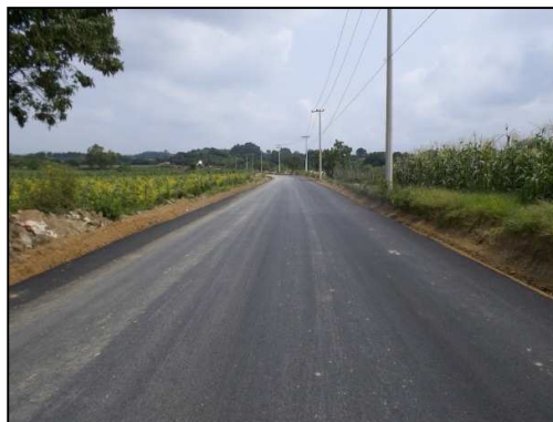
Foto 4.- Vista final con respecto a la colocación de la carpeta asfáltica.
