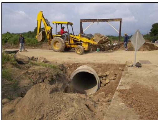
Foto 16.- Retroexcavadora Caterpillar Mod. 416 utilizada para la excavación para estructuras y obras de drenaje
