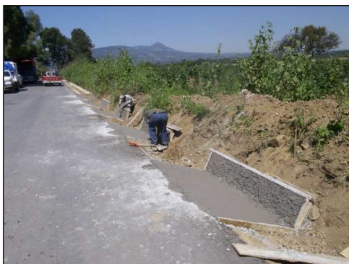
Foto 9.- En esta imagen se muestra él durante de la construcción de las cunetas.
