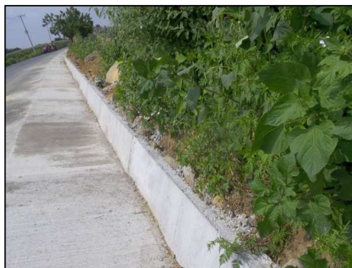
Foto 10.- Vista final de la construcción de las cunetas.
