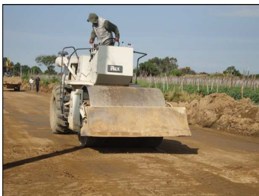
Foto 14.- Vibrocompactador rodillo liso Mod. CB534-D utilizado para la compactación.
