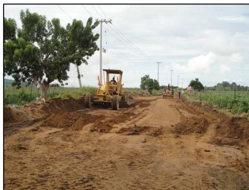
Foto 2.- Vista frontal de la maquinaria durante el despalme del terreno natural.
