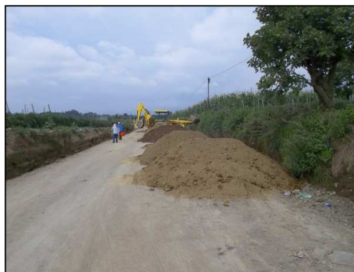
Foto 17.- Aquí se muestra el material de banco que será utilizado para conformar la base hidráulica.
