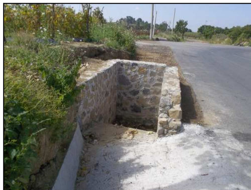
Foto 8.- Vista final del muro de mampostería y cabezote de la alcantarilla.
