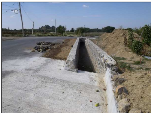
Foto 7.- Vista final de la construcción del canal de desfogue de la alcantarilla.
