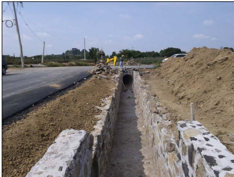
Foto 12.- Vista final de las labores de limpieza de basura para esta obra de drenaje.
