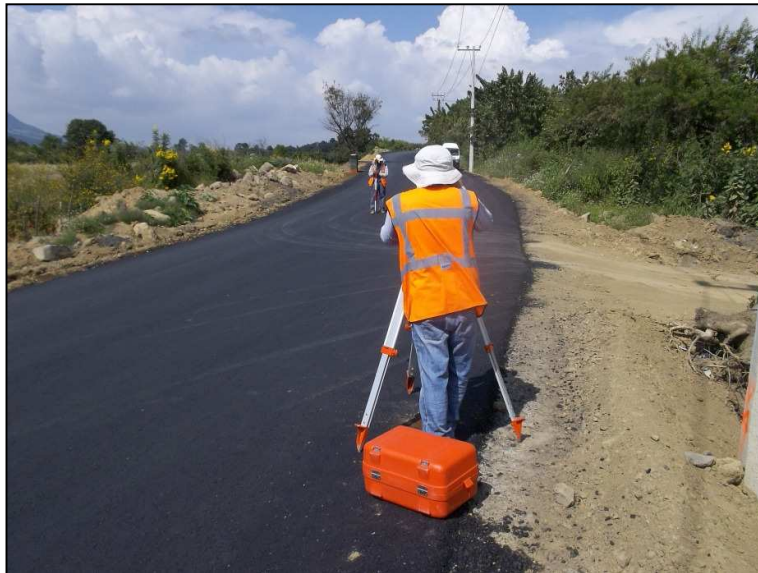
Foto 13.- Aquí se observa a la brigada de topografía de la Supervisión Externa verificando la pendiente y espesor de la carpeta asfáltica.
