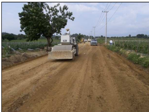
Foto 3.- Vista frontal durante la compactación de la base hidráulica.
