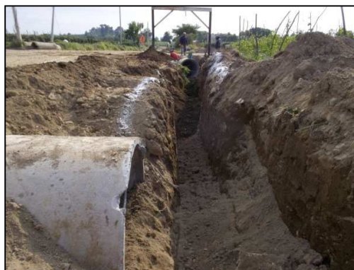
Foto 6.- Aquí se observa la excavación para la construcción de estructuras.
