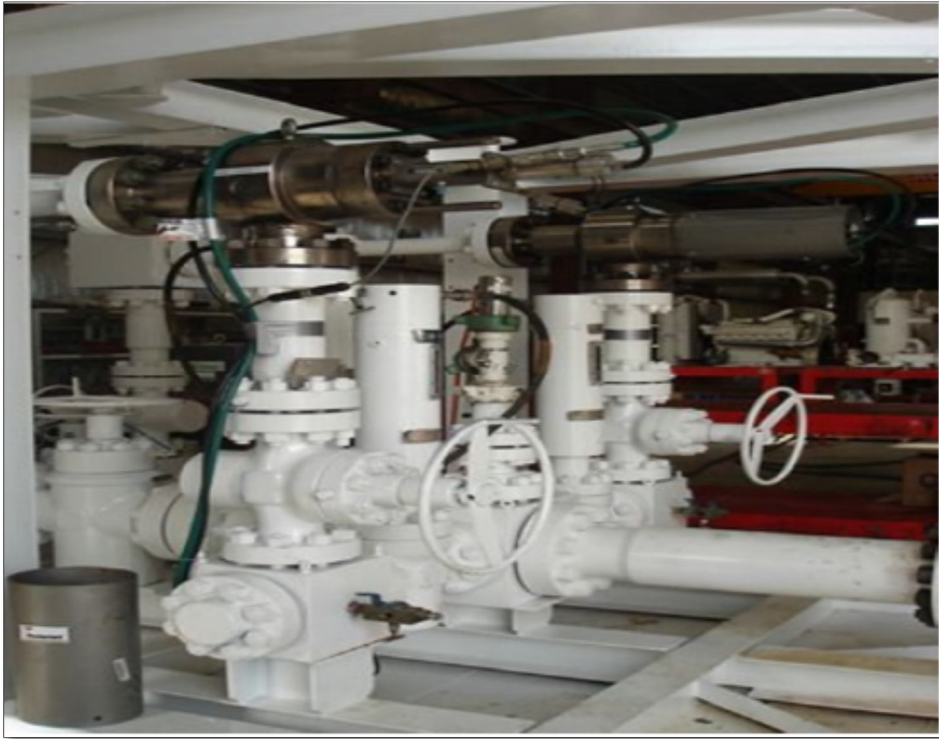
Figura 3.20 Múltiple de estrangulación semiautomático
