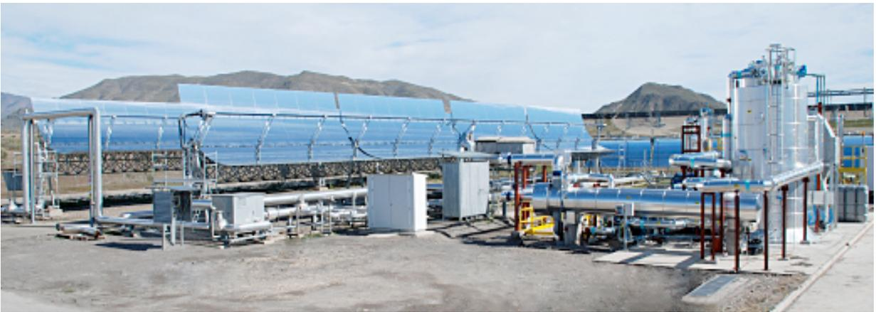
**Figura 4.11 Instalación Cilindro-Parabólica acoplada con sistema de almacenamiento de sales fundidas**
