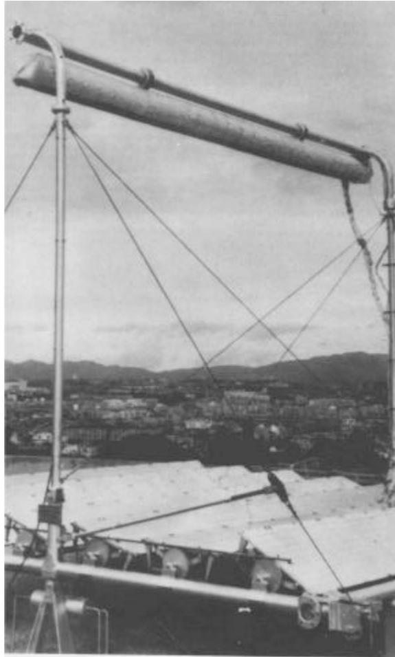
**Figura 4.9 Sistema Fresnel experimental construido por G. Francia en 1963**
