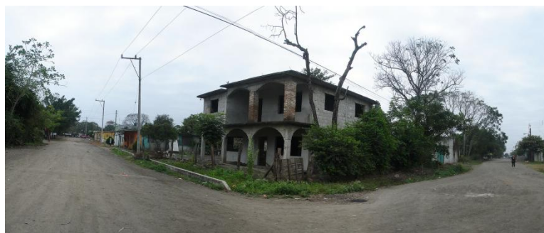
Foto real de una casa con instalación eléctrica,
