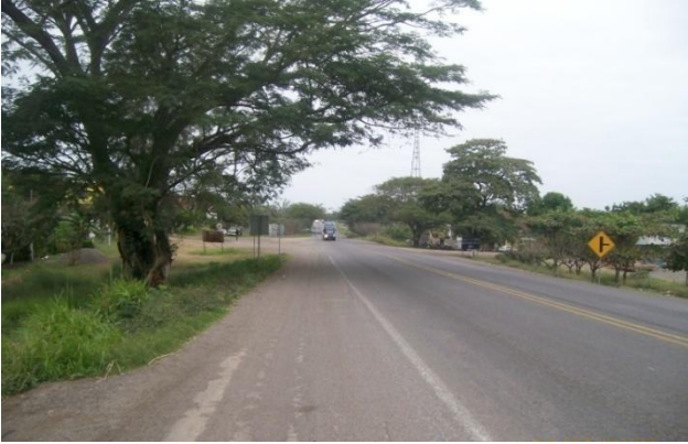
Vista de la carretera, estado actual
