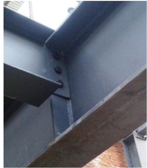
Ilustración 77 Detalle de conexión Trabe-Viga
