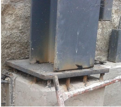
Ilustración 80 Detalle de conexión Columna-Cimentación
