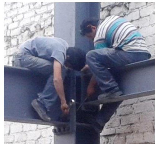
Ilustración 79 Personal atornillando trabe a columna
