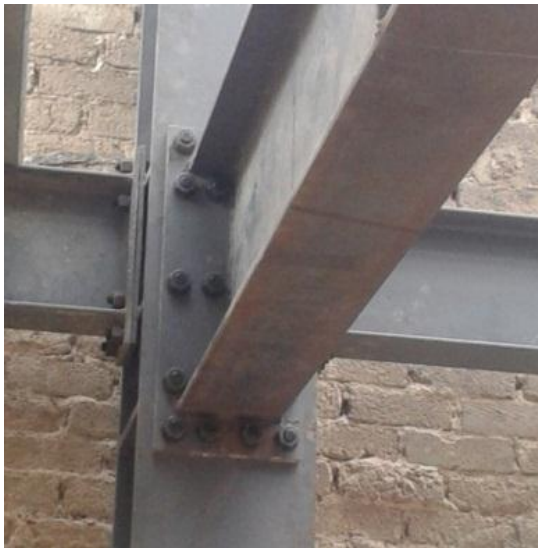
Ilustración 76 Detalle de conexión Columna-Trabe
