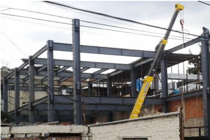
Ilustración 75 Vista general de la estructura
