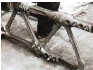
Ilustración 52 Conexiones poco usuales en acero
