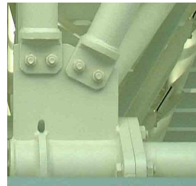
Ilustración 21 conexión a base de pernos
