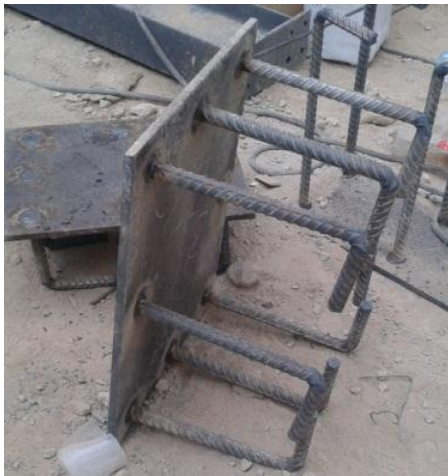
Ilustración 81 Detalle de Placa Base
