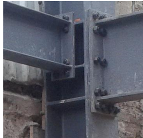
Ilustración 78 Detalle de conexión Viga-Columna
