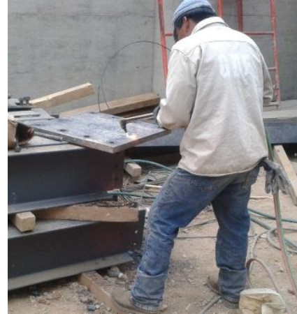
Ilustración 82 Personal en fabricación de placa base
