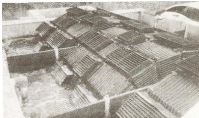
Figura 2.5. Reactor de discos rotatorios (de Envirex Inc., en Metcalf y Eddy, 1991)
