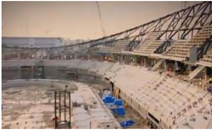
Vista interior a nivel de acceso.
