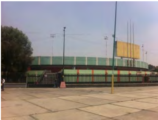
Vista de la Fachada sur desde al metro.
