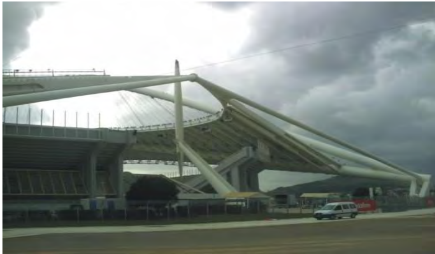
Conexiones de los arcos y cubierta del Velódromo.
