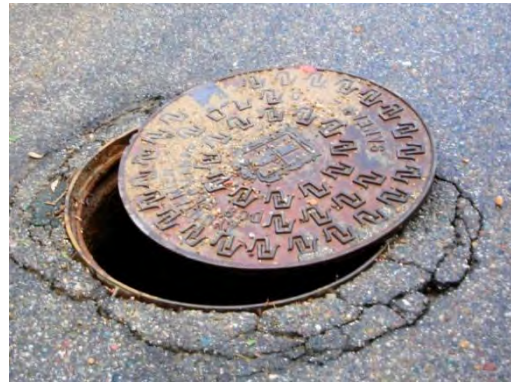
Drenaje y alcantarillado de la Ciudad de México.
