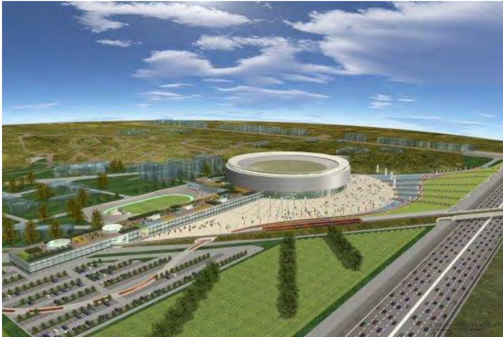
Vista general del Centro Deportivo.
