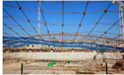
Armado de cubierta.
