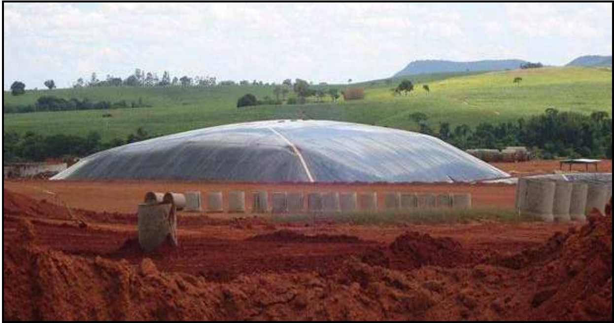
Figura 2.8 Vista de un reactor anaerobio de tipo laguna (Agenieria, 2011)
