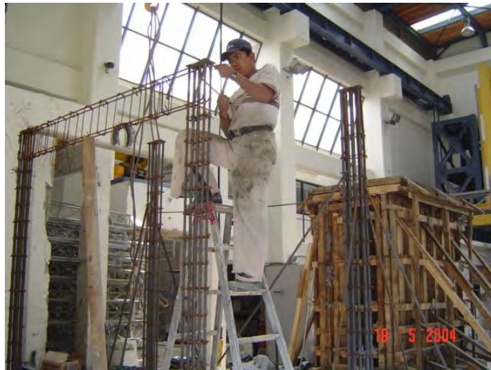
Figura L.5 Colocación del armado de la viga superior
