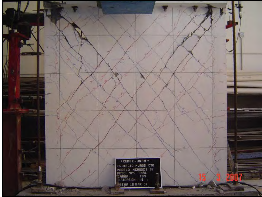
Figura S.37 Estado final de daño del muro MCA50C2
