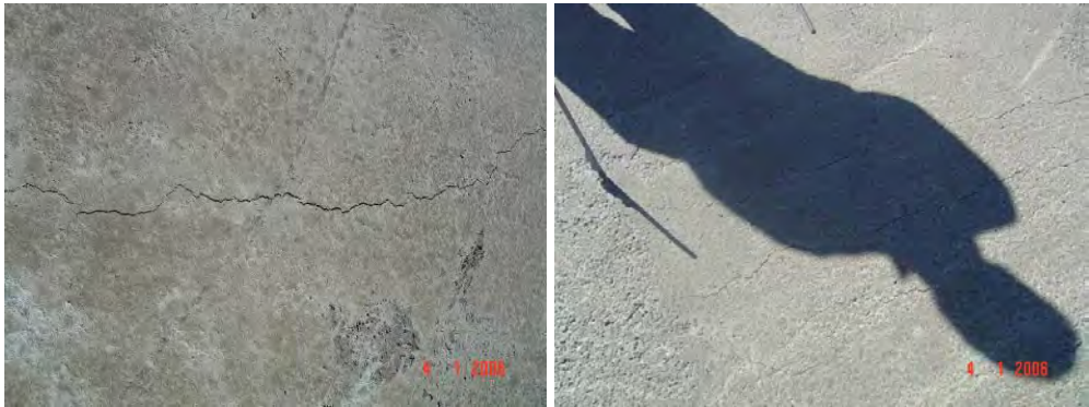
b) Agrietamiento en losas (continuación)
