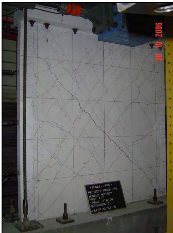
Figura S.35 Estado final de daño del muro MCC50C2
