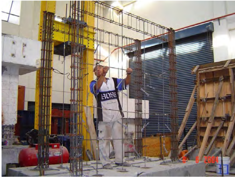
Figura L.6 Colocación de acero del alma de los muros
