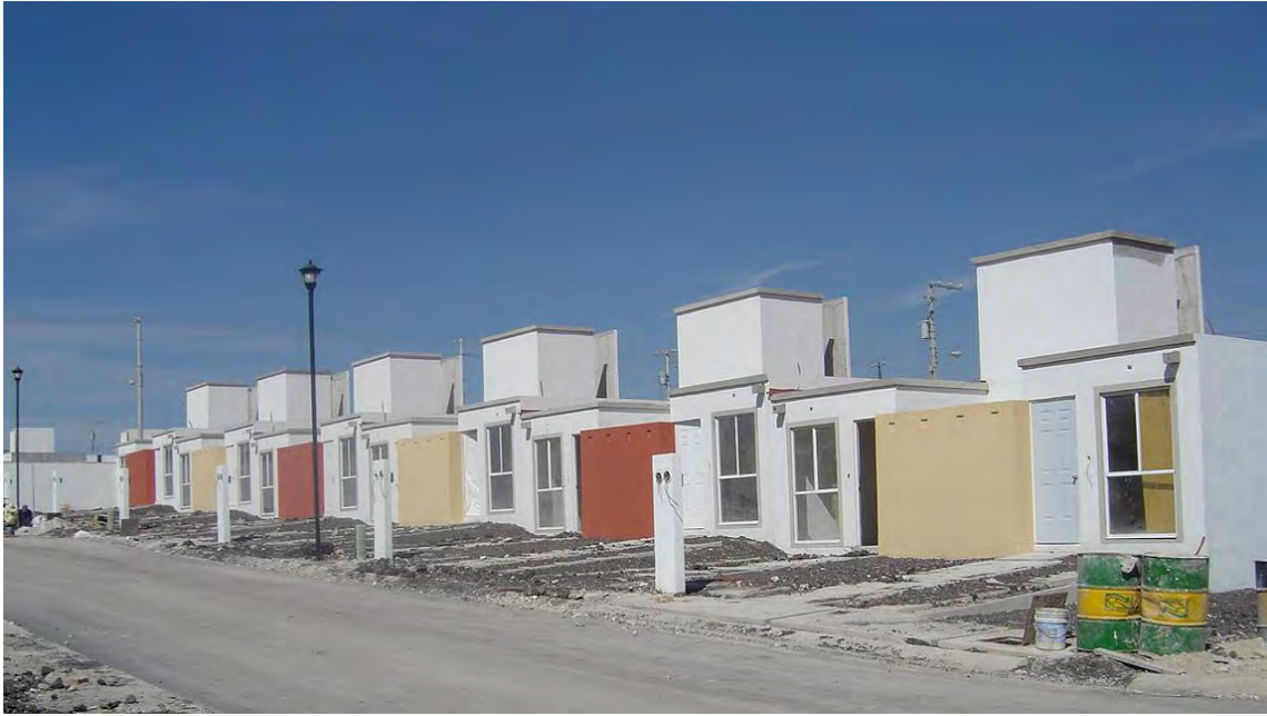
Figura 2.18 Viviendas de concreto terminadas
