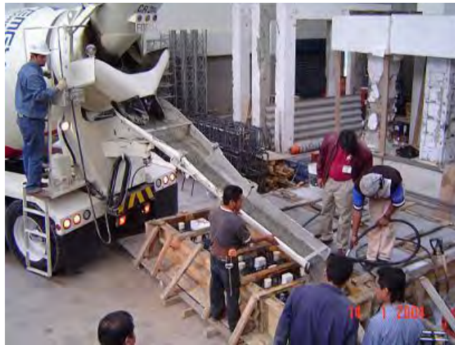
Figura L.3 Colado de cimentaciones
