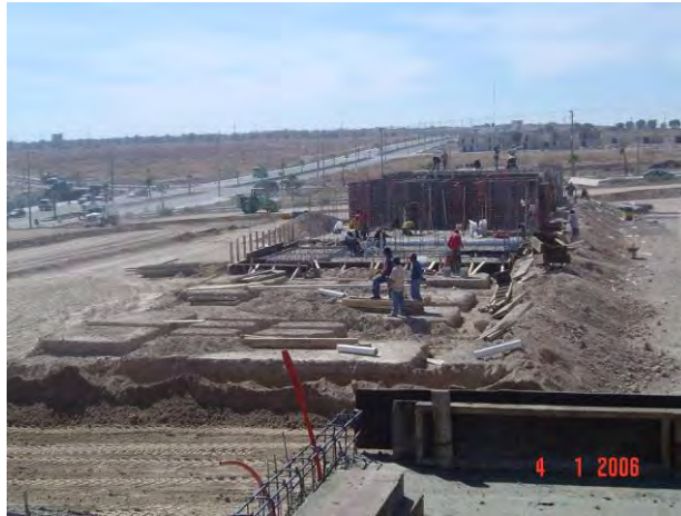
Figura B.1 Preparación de la base de cimentación de un grupo de viviendas típicas de concreto
