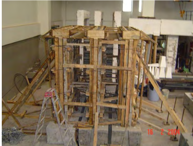
Figura L.10 Disposición de los muros previa al colado
