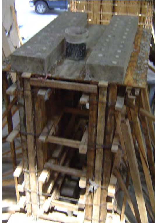
Figura L.13 Muros de concreto autocompactable
