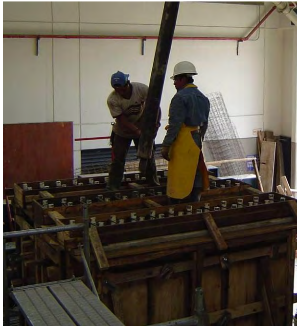
Figura L.12 Colado de muros de concreto celular
