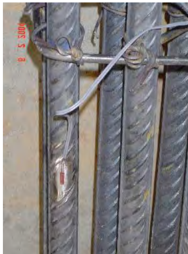
Figura O.4 Deformímetro adherido a una barra de refuerzo del # 5
