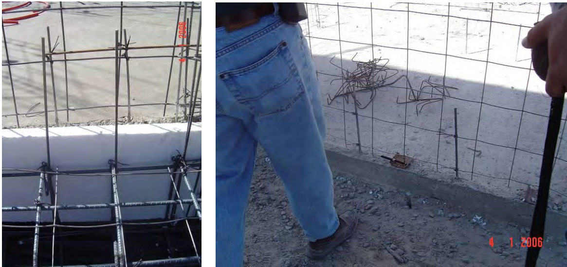
Figura B.3 Anclaje de la malla electrosoldada a la losa de cimentación
