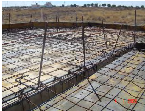
Figura B.6 Anclajes para dar continuidad a los muros de concreto en viviendas de dos niveles.
