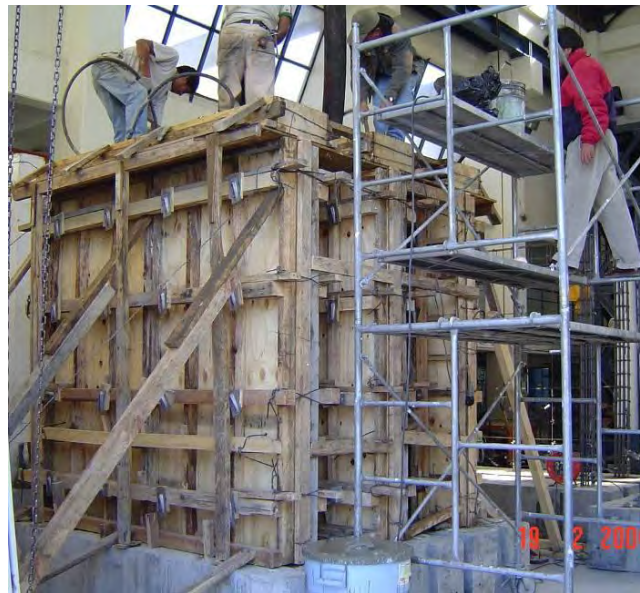
Figura L.11 Colado de muros de concreto de peso normal
