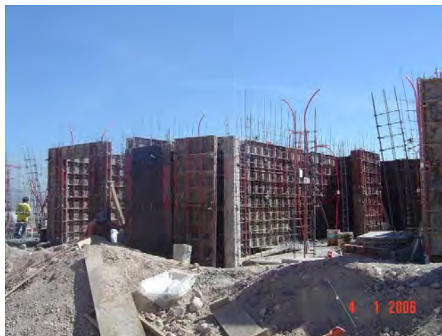
Figura B.4 Arreglo de la cimbra para el colado de muros de concreto en viviendas
