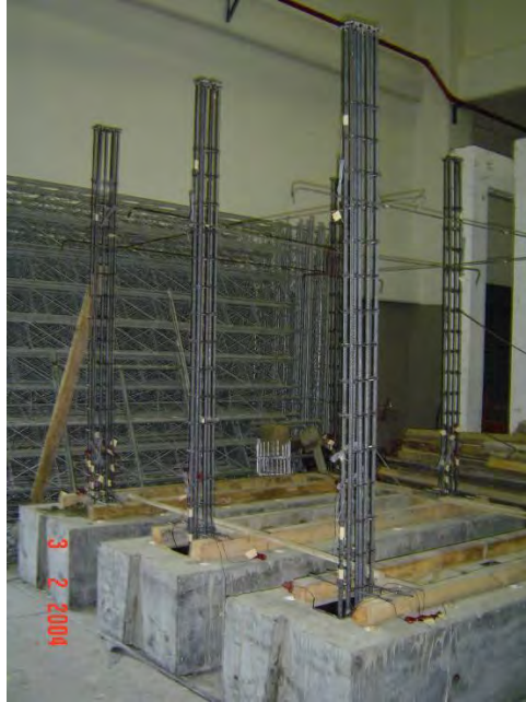
Figura L.4 Colocación del acero de los elementos de borde
