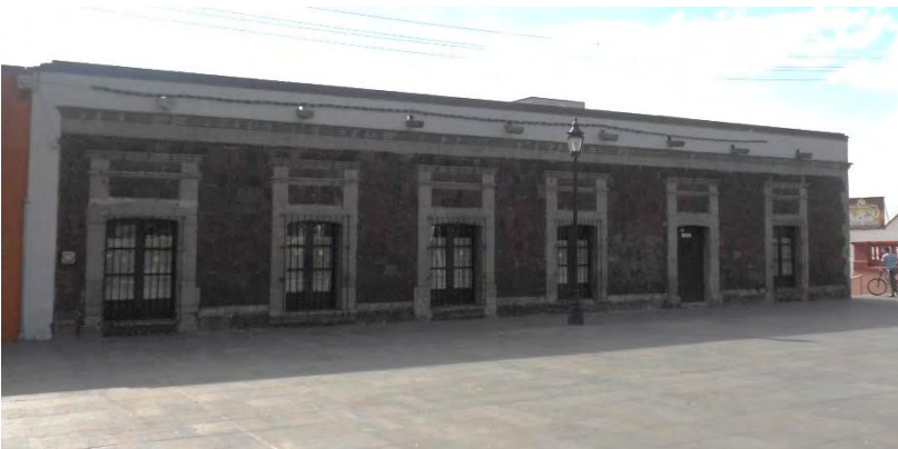
Inmueble del siglo XVIII con las características jambas de piso a techo en puertas y ventanas
