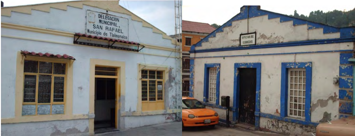
Edificios de servicio público de San Rafael
