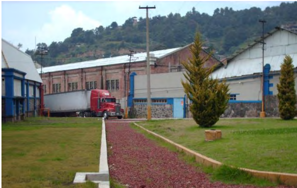
Interior de la fábrica de San Rafael, área de bodegas
