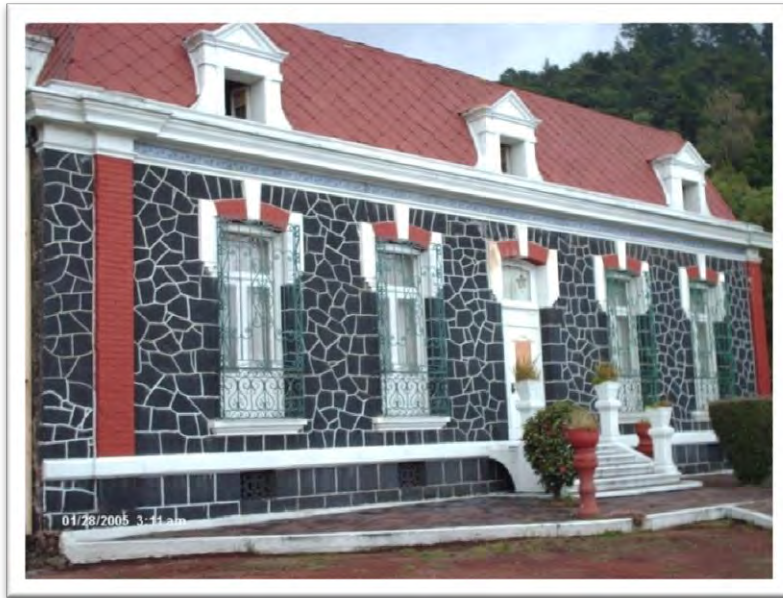
Portada de la casa de visitas al interior de la fábrica
