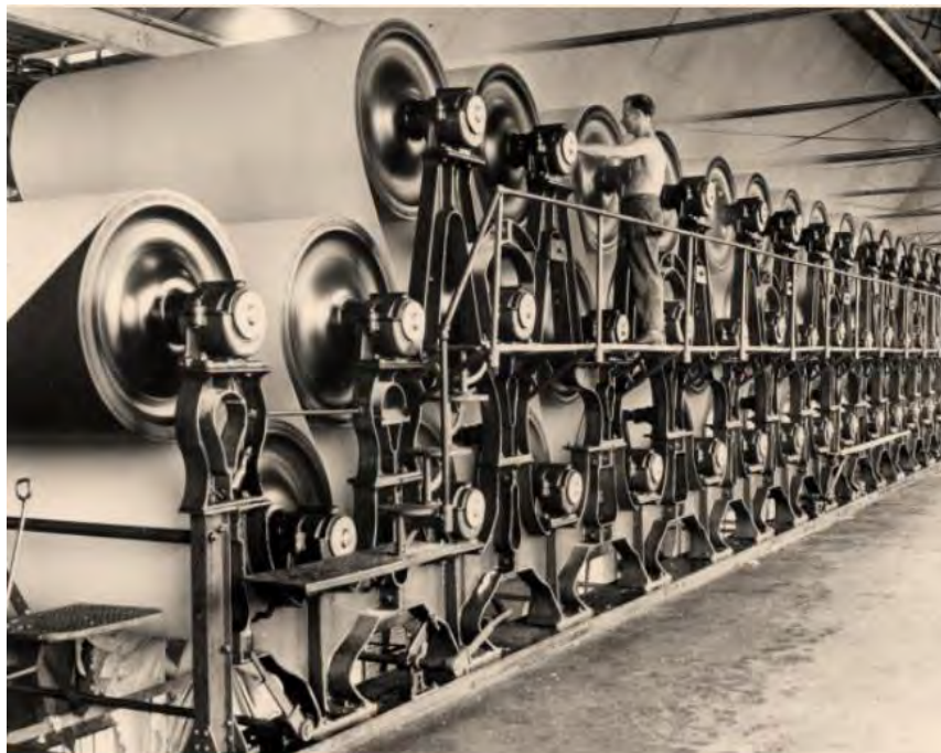
Máquina de manufactura de papel distribuida por los hermanos Fourdriner
