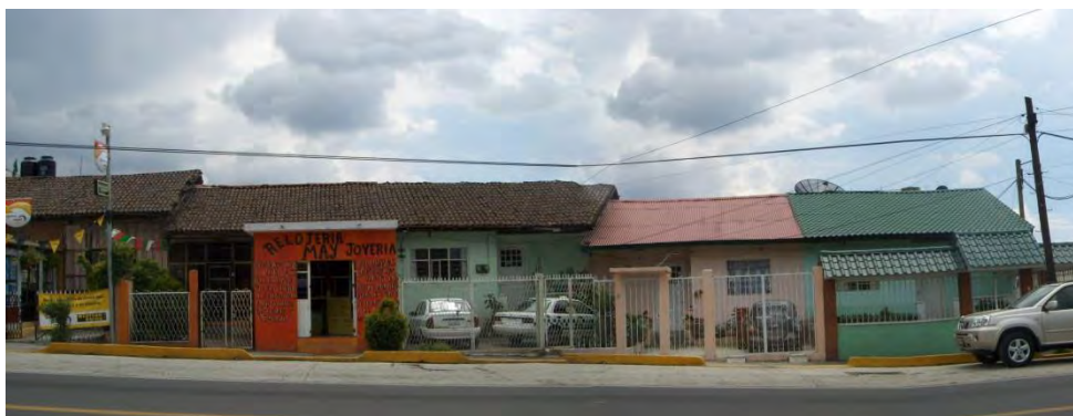
Agregados de locales comerciales al frente de las viviendas
