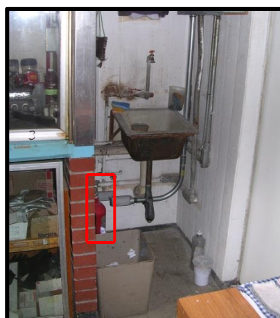
Figura A.4.6. Áreas para residuos peligrosos no determinada y extintor en área poco visible.
