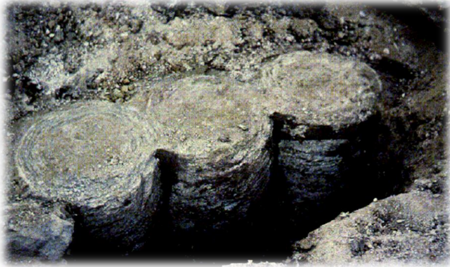
Figura 2.3. Columnas superpuestas mezcladas in-situ (Rodríguez, 2001).
