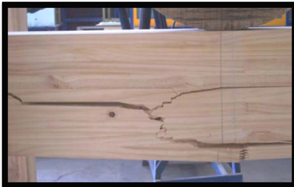
Fig. 3.2 En la figura que se presenta ocurrió el inicio de la falla en el mismo sitio de unión artificial de la viga laminada por los mismos motivos, desarrollándose una grieta hacia la zona de momento flexionante puro y otra por deslizamiento propiciado por cortante, en la zona de fuerza cortante.
