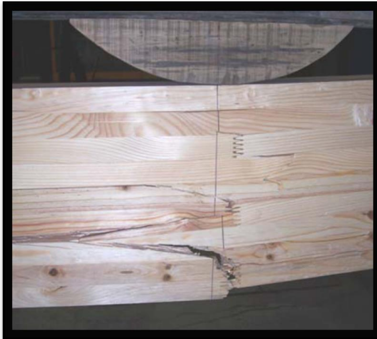
Fig. 3.1 se observa que la falla en la viga laminada fue por motivo de esfuerzos normales de tensión, en el sitio donde el momento flexionante fue máximo, el detalle indica que esta falla apareció donde se genera la unión en la fabricación de la viga.
