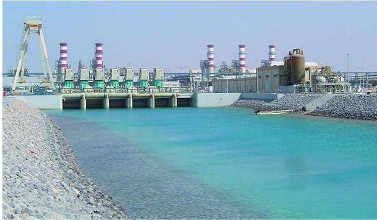
Figura A.5 Obra de toma abierta para sistemas de desalación por ósmosis inversa
