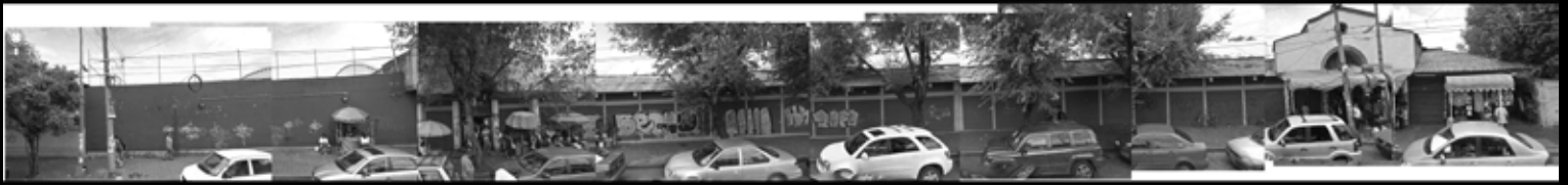
Levantamiento fotográfico fachada Xicotencatl.
