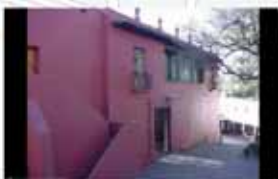
Iglesia del Altílo.
