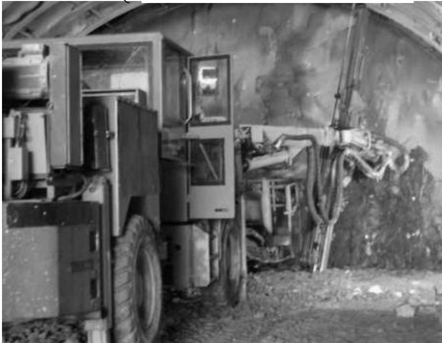
Figura 28.- Barrenación Horizontal de 3.4 m
