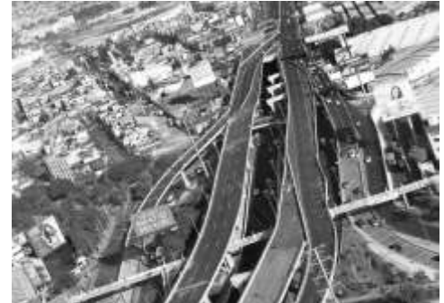
Imagen 22. Primer tramo del segundo piso del Periférico en la parte Norte que se conecta con el Viaducto Bicentenario del Estado de México. Foto de: Julio Vargas / El Sol de México, 4 de Noviembre del 2011.
