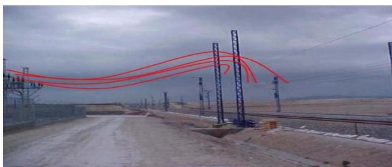
4.14.6 Imagen de la conexión de los feeders hacia las catenarias
