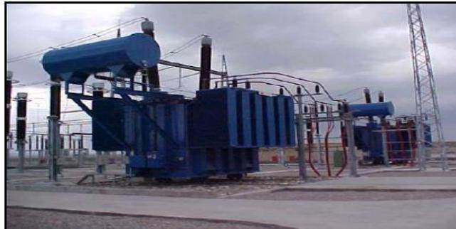
Figura 4.14.3 El transformador de tracción
