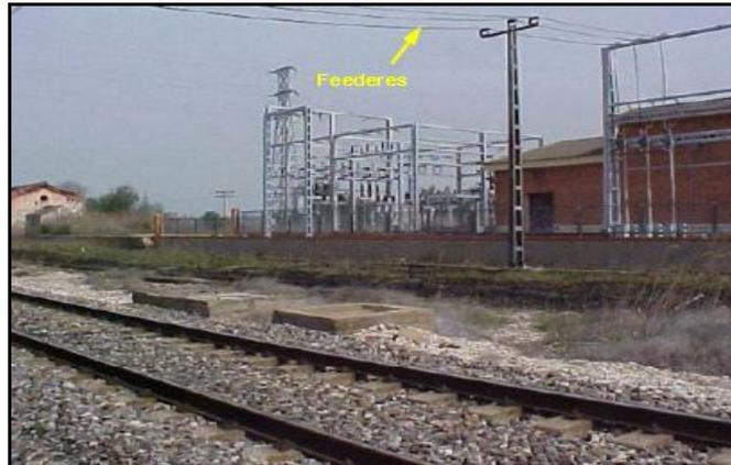
Figura 4.14. 4 Imagen donde se puede apreciar la salida de los feeders de la subestación de tracción hacia las catenarias.
