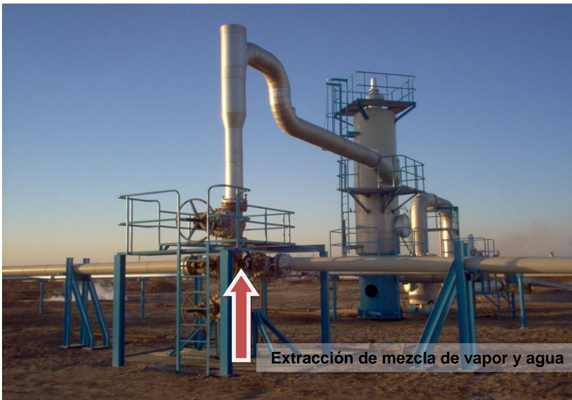
Figura 3. Pozo geotérmico Cerro Prieto, B.C. (Extracción de mezcla de vapor y agua proveniente de yacimiento geotérmico a profundidades mayores a 2000 metros)
