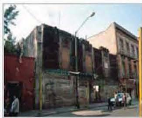
Última foto conocida del inmueble antes de ser demolido.
