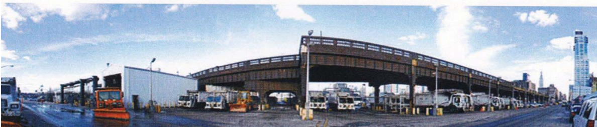
Predio desde la calle 30 vista Norte
