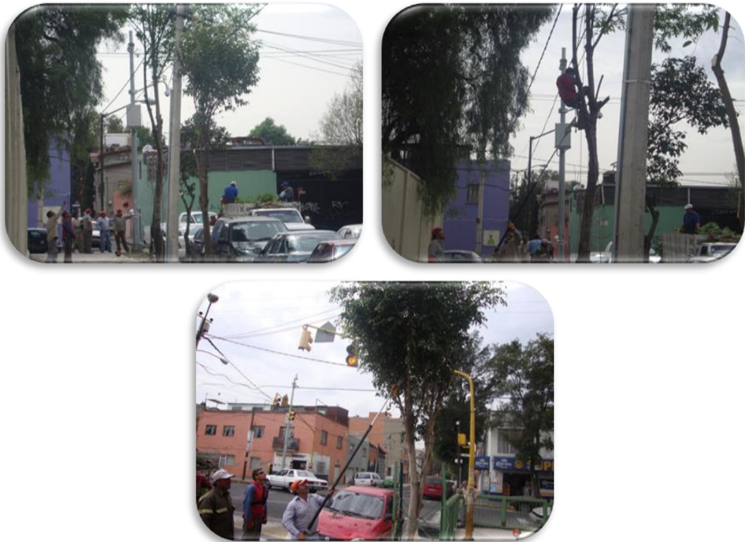
Figura 3.1.1 Poda de árboles para liberar cámaras de seguridad
