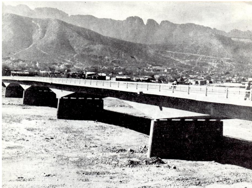
Figura 1.3 Puente Pino Suárez, Monterrey, N.L.
