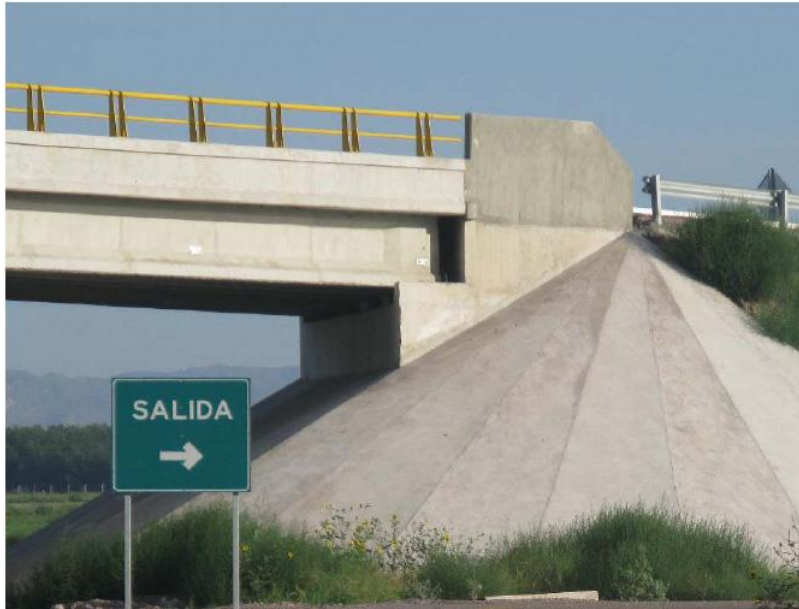
Figura 1.21 Estribo de Concreto del Ent. Lázaro Cárdenas, Chihuahua (SCT)
