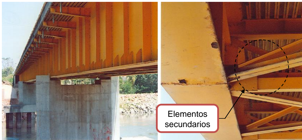
Figura 1.18 Superestructura del Puente Pigua II, Tabasco (SIPUMEX)
