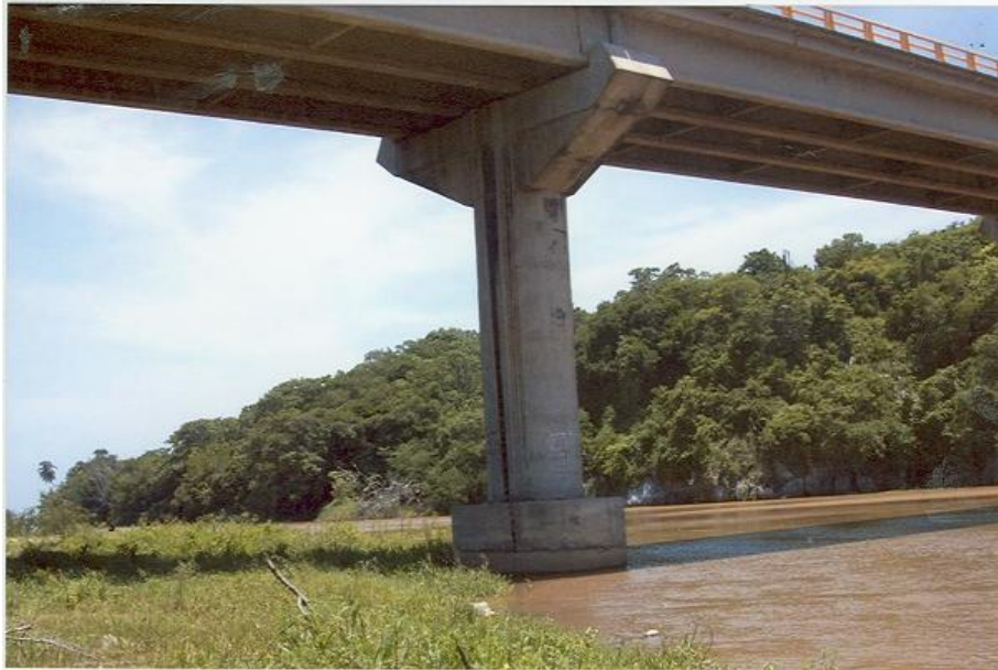
Figura 1.22 Columna o Pila central del Puente Nexpa, Michoacán (SIPUMEX)
