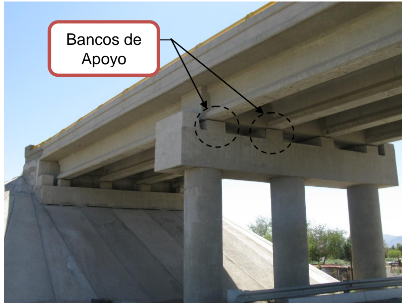
Figura 1.28 Puente ubicado en el Libramiento de Mexicali Km. 11+700, en Baja California Norte (SIPUMEX)
