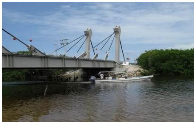
Figura 1.12 Puentes colgantes soportados por torones de presfuerzo (SCT)
