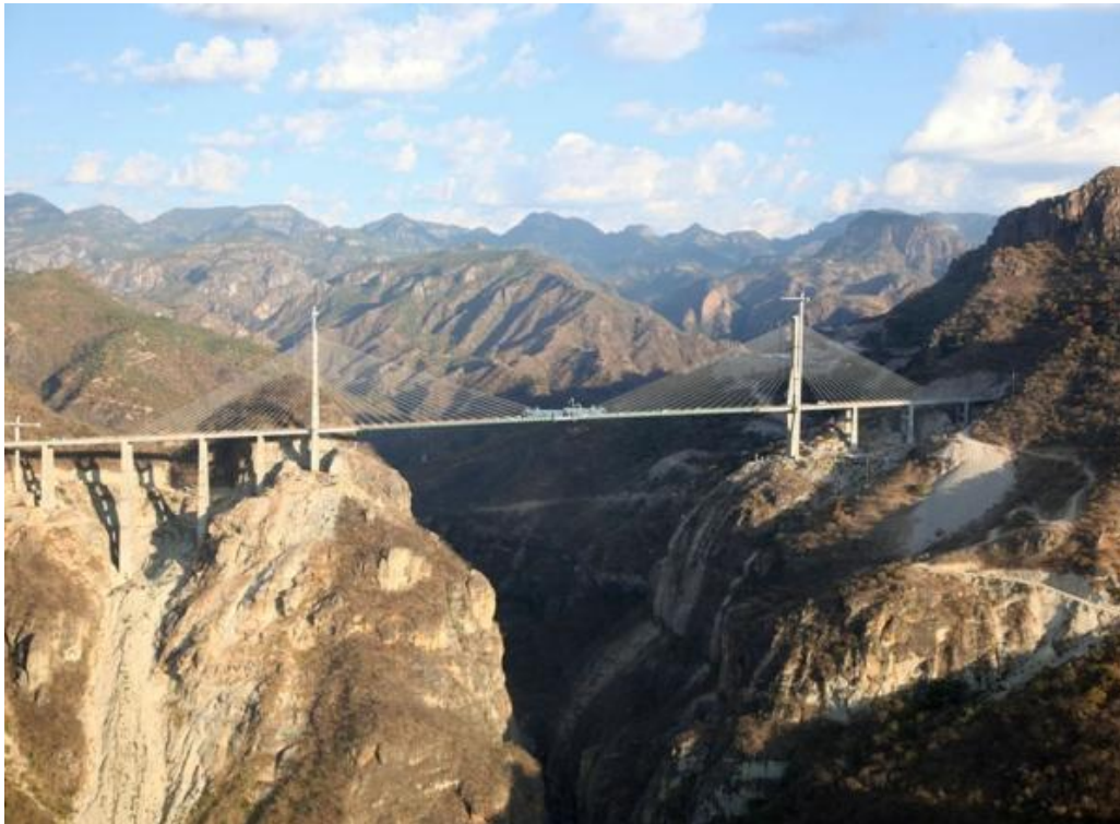
Figura 1.7 Vista general del Puente Baluarte (SCT)
