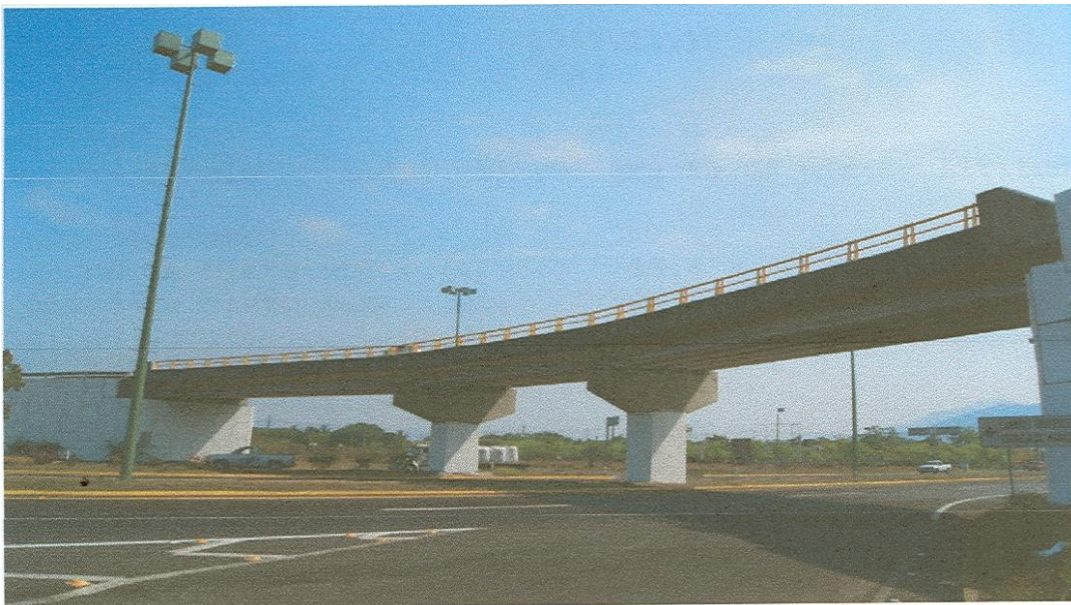
Figura 1.14 Paso a desnivel del Puente Tecomán, Colima (SIPUMEX)
