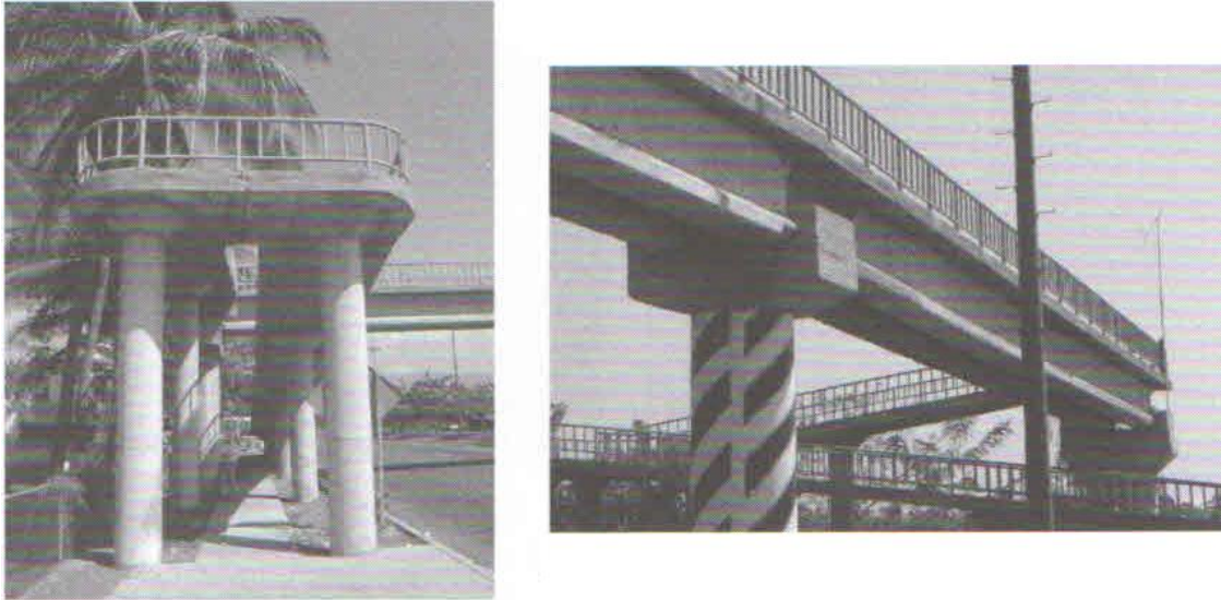
Figura 2.30 Puente peatonal en Tecomán
