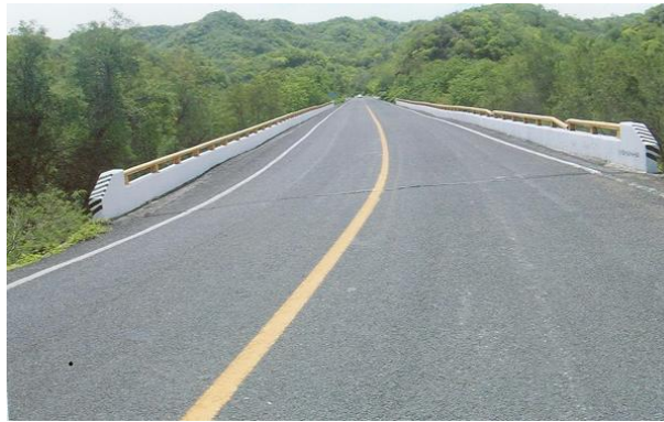
Figura 1.19 Superficie de rodamiento del Puente Motín del Oro I, Michoacán (SIPUMEX)
