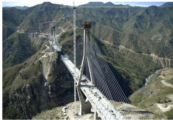
Figura 1.11 Puentes atirantados con cables de acero (GRUPO TRADECO)
