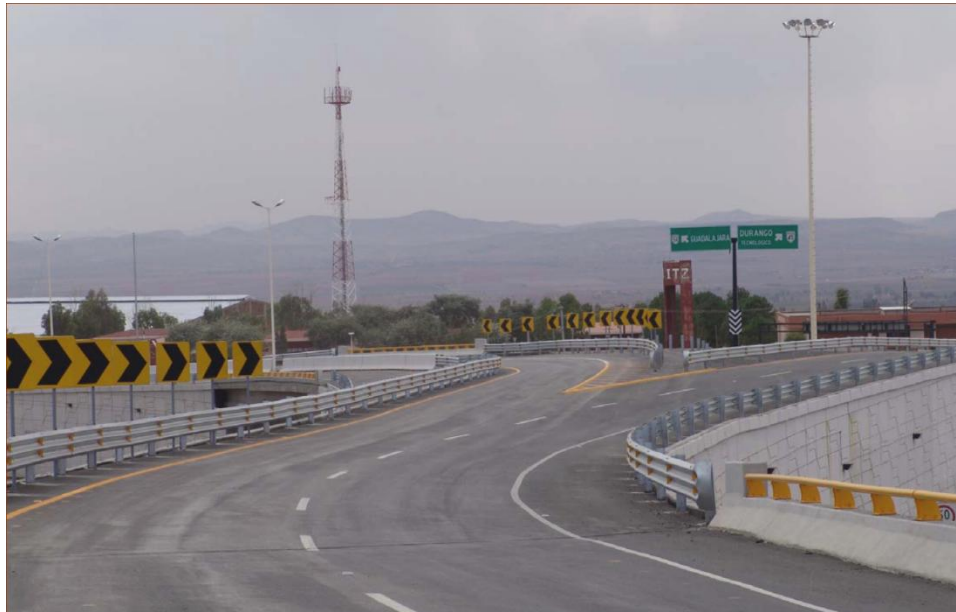
Figura 1.42 Señalamiento y letreros viales (SCT)
