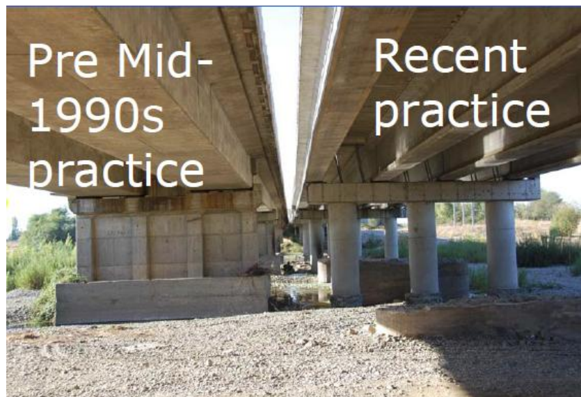
Figura 2.34 Puentes construidos con diferentes reglamentos de construcción
