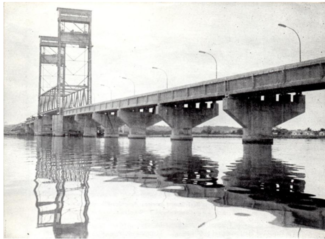
Figura 1.5 Puente Coatzacoalcos, Carretera Coatzacoalcos – Puerto Juárez
