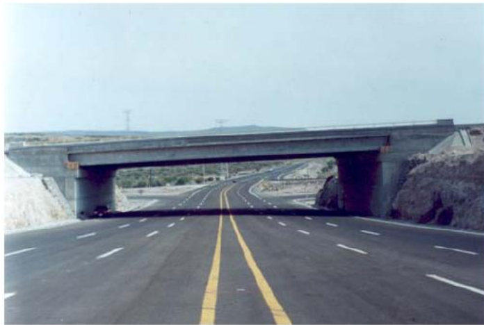
Figura 1.8 Puente con vigas simplemente apoyadas (SCT)
