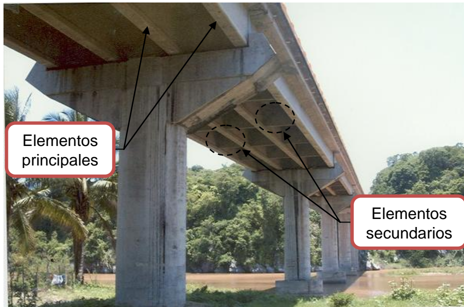
Figura 1.16 Vista lateral de la estructura del Puente Nexpa, Michoacán (SIPUMEX)
