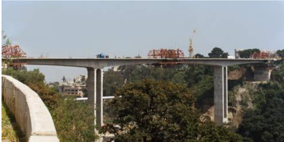
Figura 1.13 Puente con sistema de vigas en doble voladizo (MEXPRESA)
