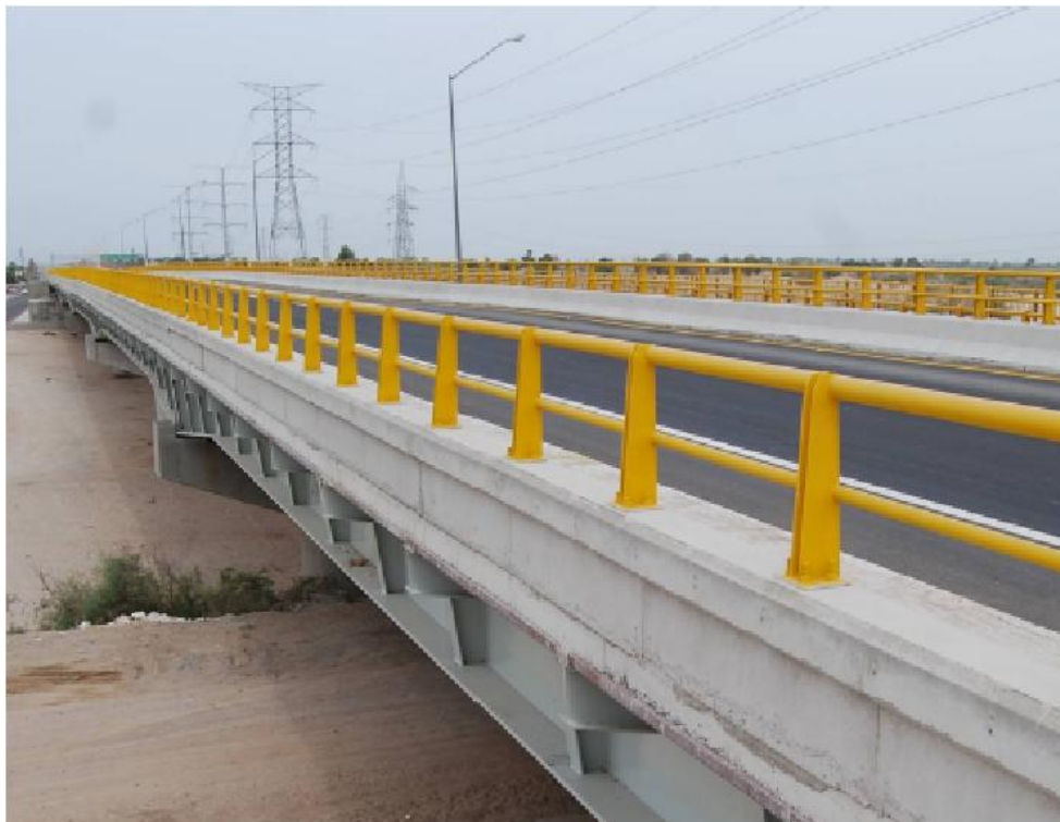
Figura 1.41 Parapeto de estructura metálica (SCT)
