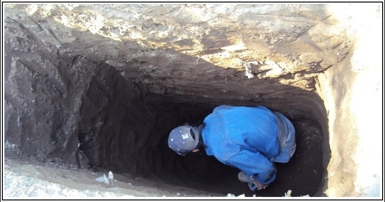
FOTO No. III.9- Se muestra personal de la empresa contratista dentro de la excavación para el primer sondeo del terreno.
