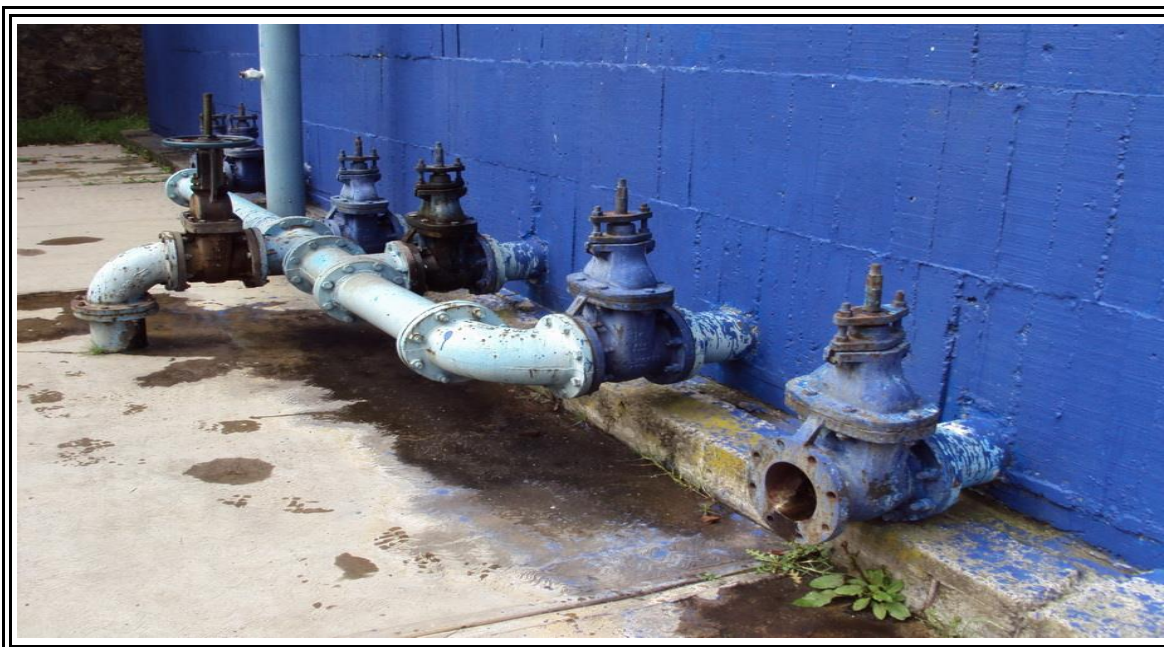
FOTO No. III.3.- Se muestran las diferentes salidas del tanque en acero de 6" de diámetro con sus válvulas de seccionamiento para salir en una sola línea de 6" diámetro.
