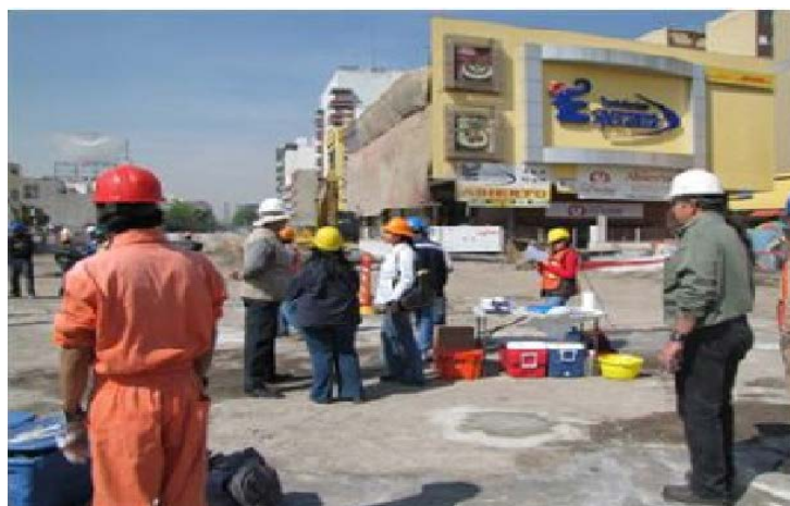
Figura No. 17 Reunión con personal del panel interinstitucional e inicio de trabajos de campo
