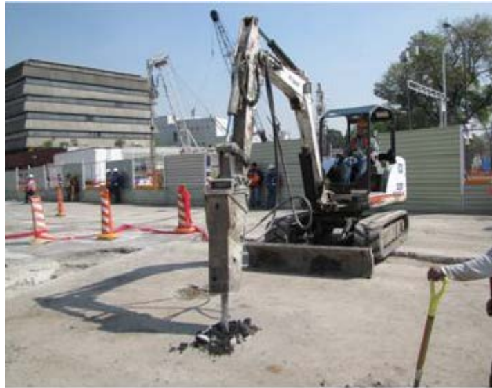
Figura No. 20 Rompimiento de la carpeta asfáltica y concreto hidráulico.
