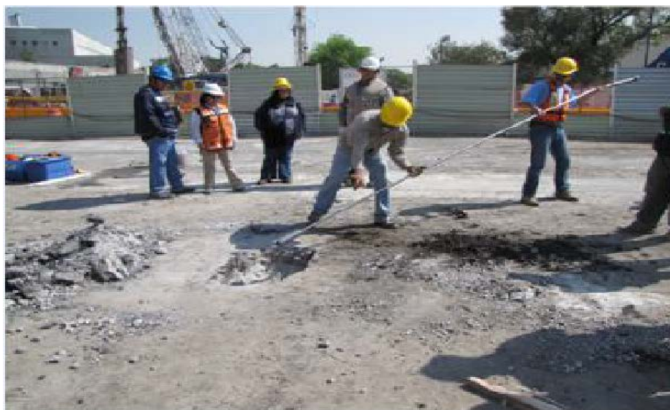
Figura No. 18 Realización de los sondeos preliminares para la toma de muestras de suelo y subsuelo.
