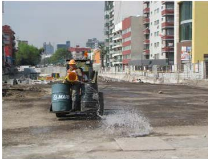
Figura No. 21 Regado de agua en área de trabajo.
