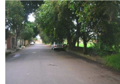
Lindero suroeste del terreno a ocupar, carece de banqueteta y solo cuenta con guarnición.
