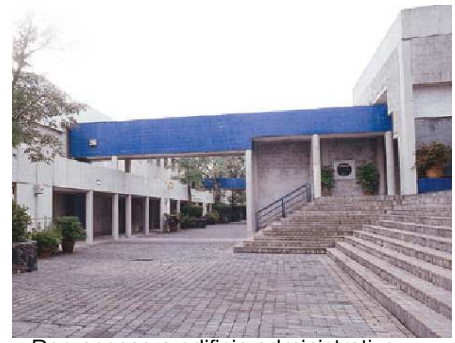
Der. acceso a edificio administrativo. Izq. Almacén.
