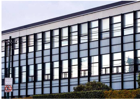
Fachada principal del edificio de oficinas, sobre Miguel Ángel de Quevedo.
