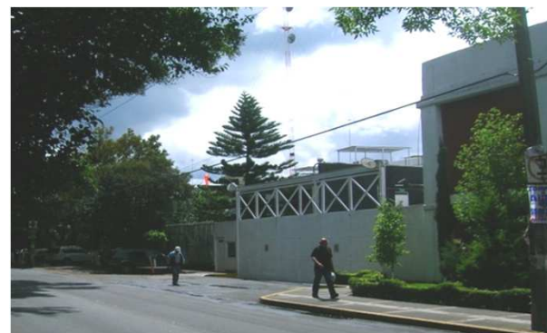
Acceso principal de la Fábrica Fuller sobre calle Redención.
