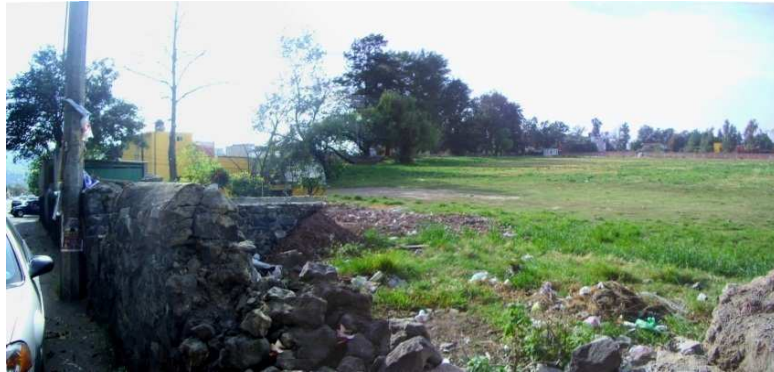
Vista frontal hacia el interior del terreno, sobre la calle Redención.
