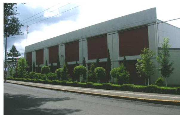
Fachada principal Fábrica Fuller sobre calle Redención.
