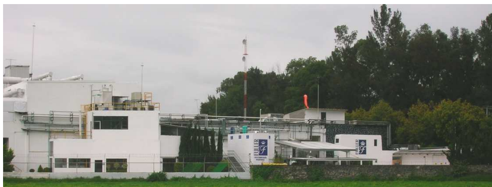
Se observa a través del predio a ocupar, el conjunto de la Fábrica Fuller.
