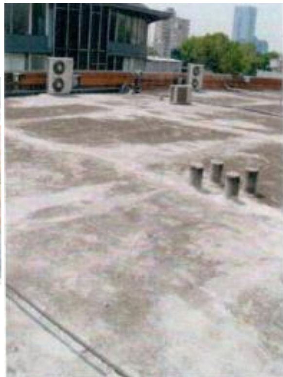
Figura 6.1.8.35 Azotea de la Universidad
