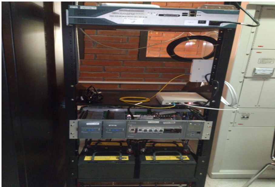
Figura 6.4.7. Rectificador y enlace de internet
