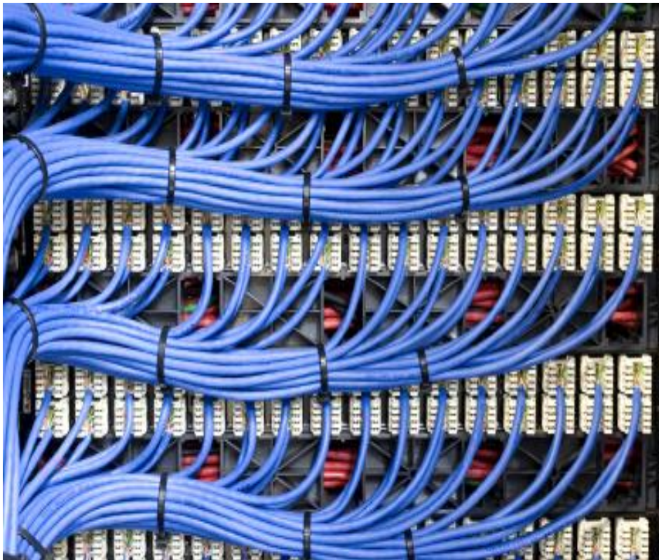
Figura. 1.2.1 Estructura o sistema de cableado
