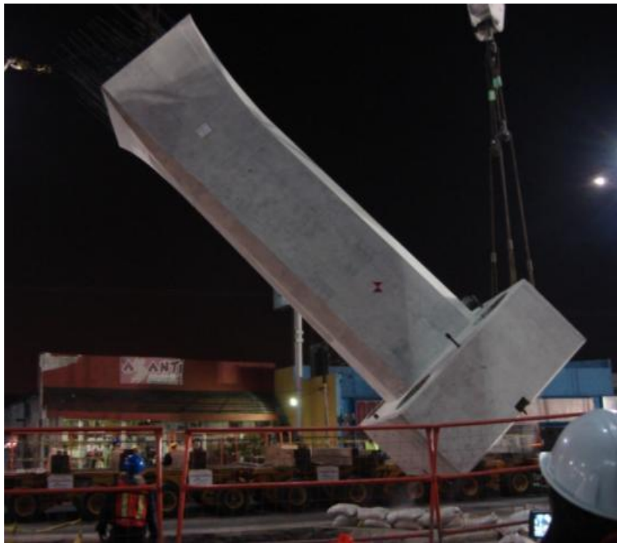
Ilustración 62. “Montaje de columna”
