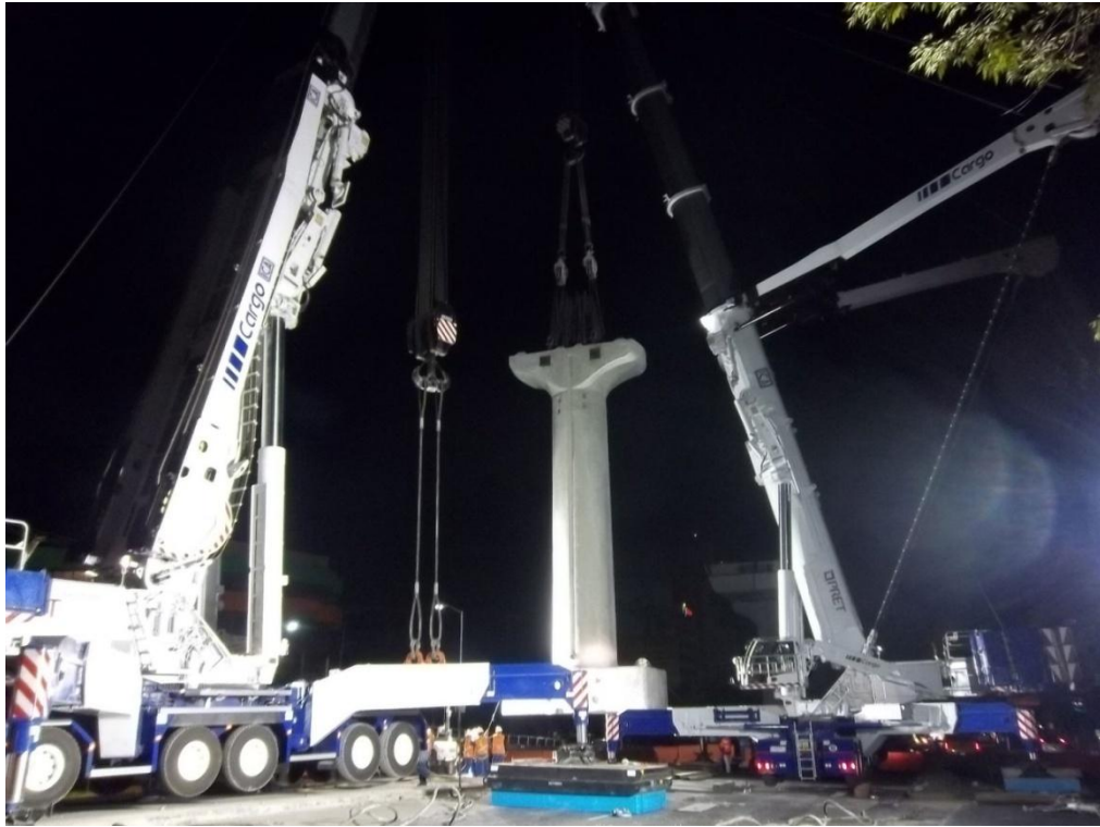
Ilustración 64. “Montaje de columna para 4 carriles”
