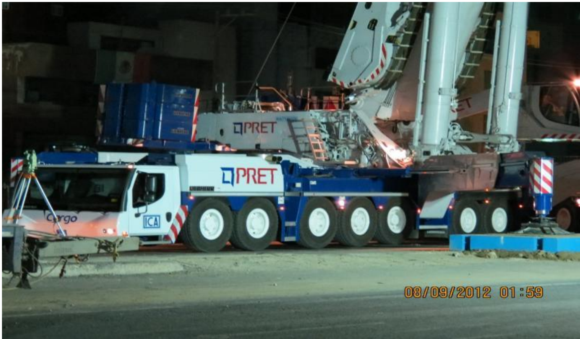
Ilustración 73. “Grúa de 1200 tons en acción”
