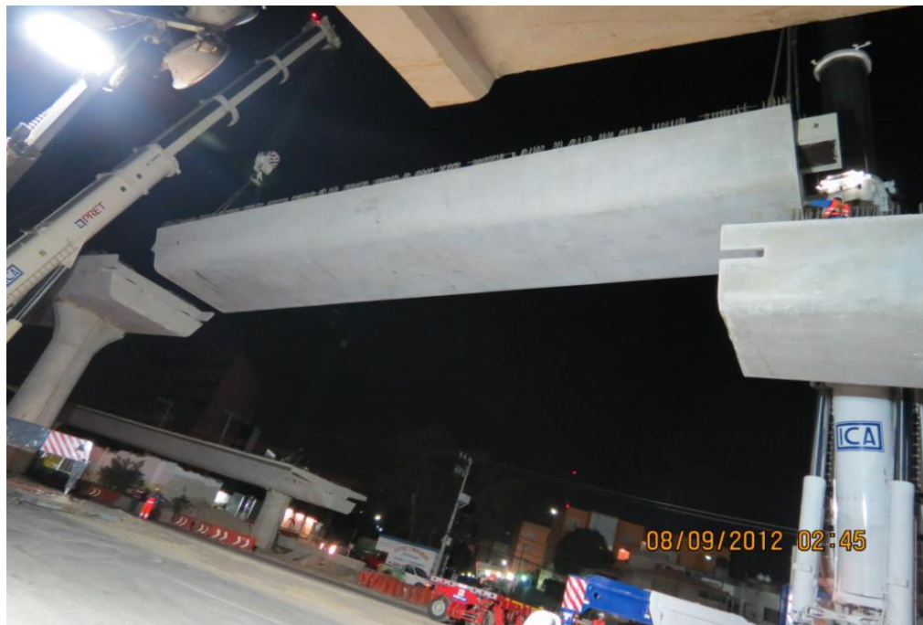
Ilustración 70. “Montaje de trabe de conexión”
