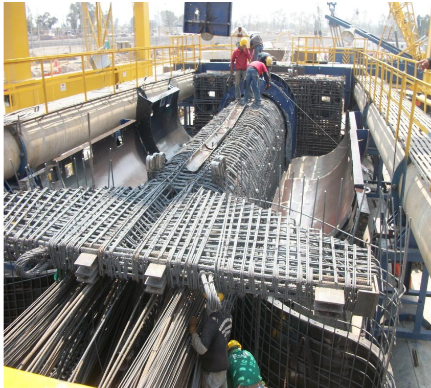
Ilustración 39. "Armado de Columna"
