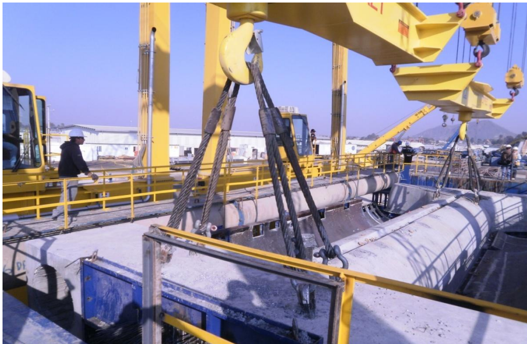
Ilustración 46. “Transporte con grúa dentro de la planta”
