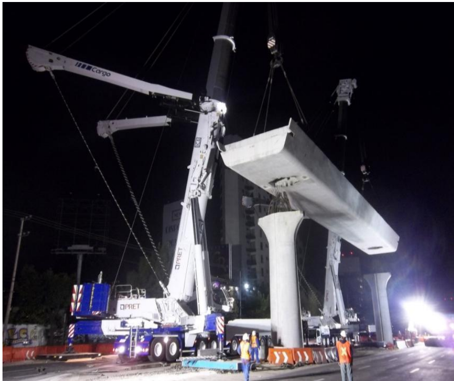
Ilustración 65. "Montaje de travesa en columnas"
