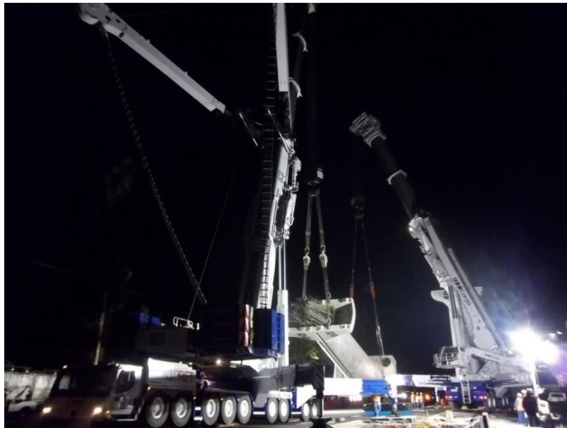
Ilustración 61. "Montaje de columna"
