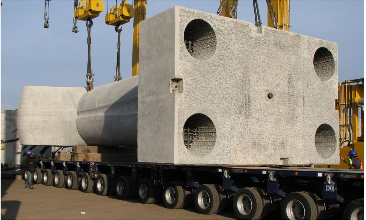
Ilustración 41. “Montaje de Columna en modular para transporte”
