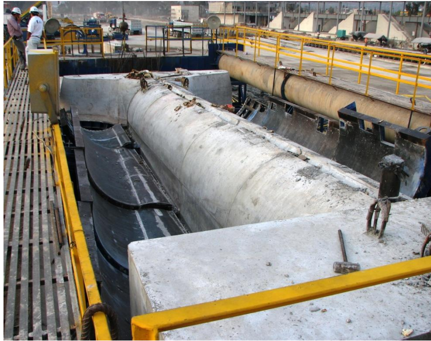
Ilustración 40. “Descimbrado de columna”
