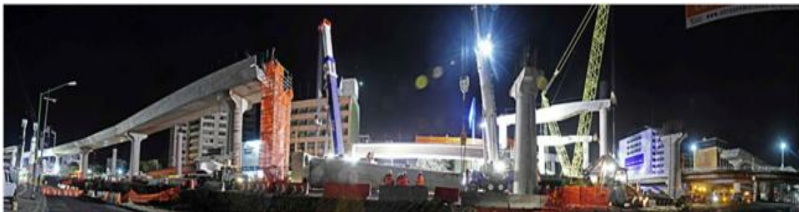
Ilustración 24. "Montaje de traves ballena"
