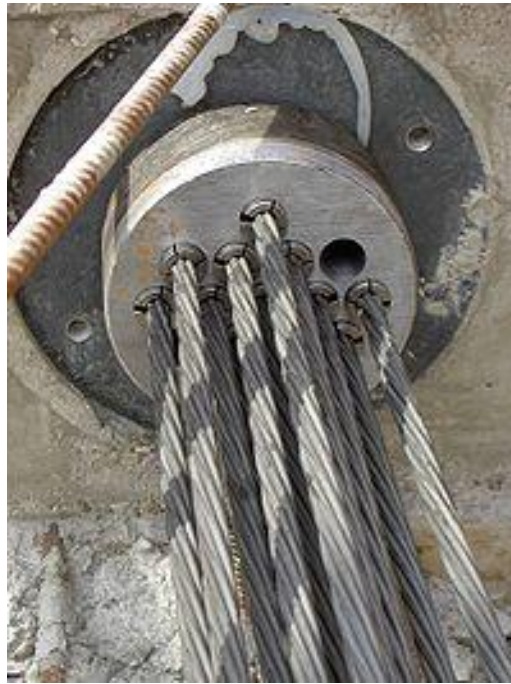
Ilustración 16. “Placa de anclaje de los cables de postensado en un puente”
