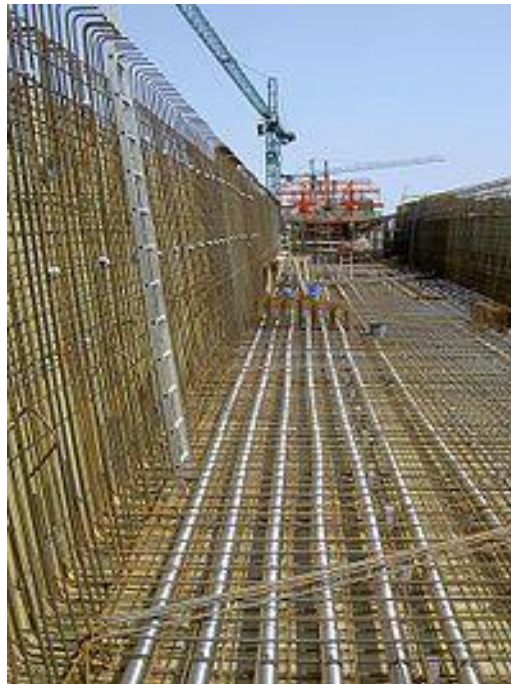
Ilustración 15. “Armado de trabe tipo ballena con ducto de acero para postensado”
