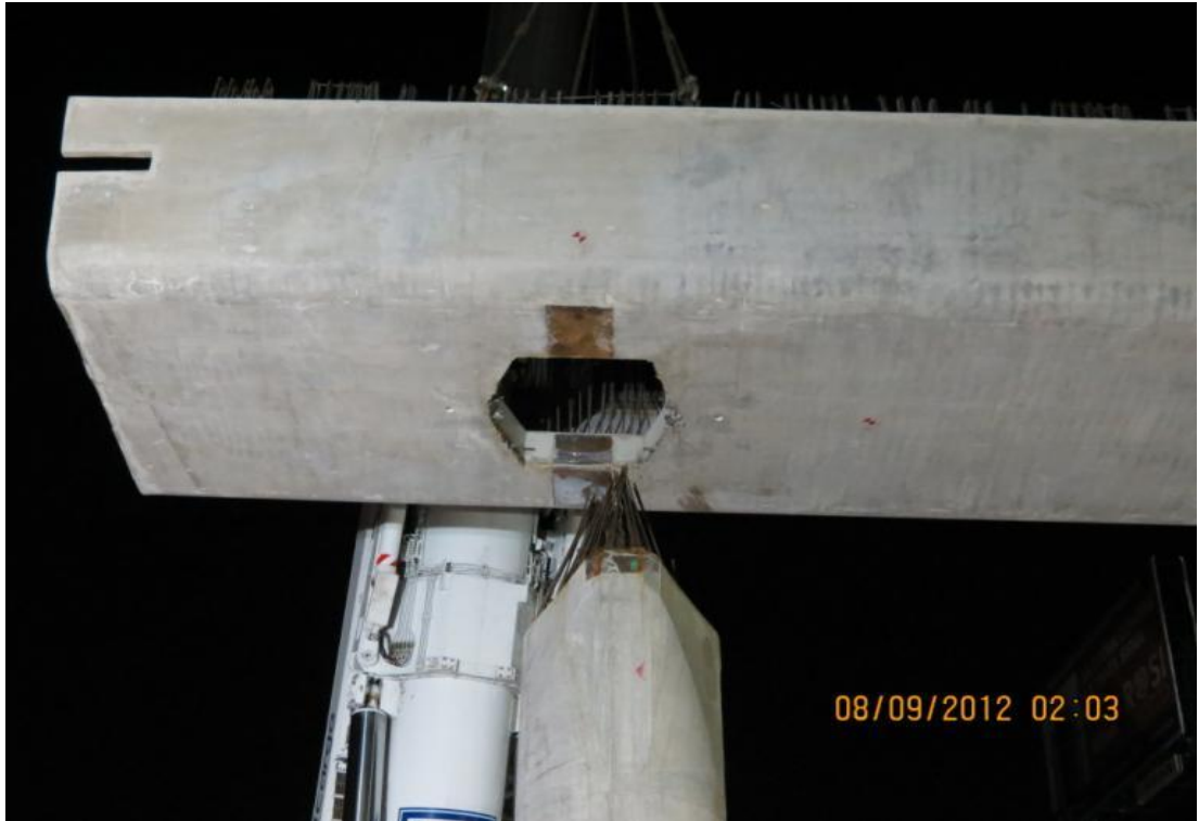
Ilustración 66. "Montaje de trabe en columna"
