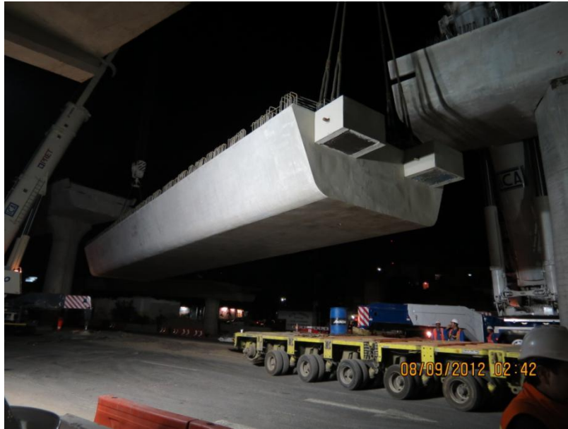
Ilustración 60. "Montaje de trabe"
