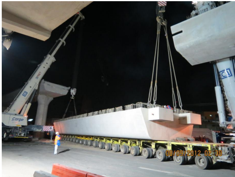
Ilustración 59. “Grúas de 1200tons listas para elevar elemento”
