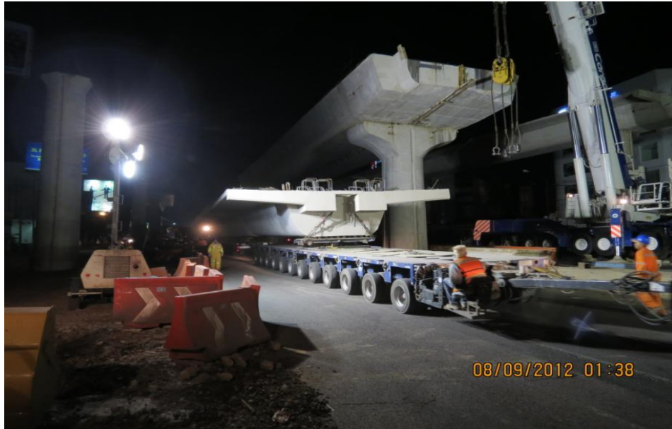
Ilustración 58. “Llegada de trabe a sitio de montaje”
