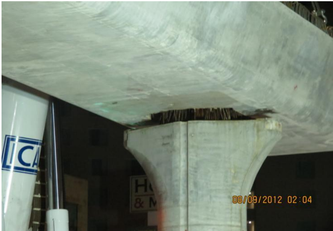
Ilustración 67. "Montaje de Trabe en columna"
