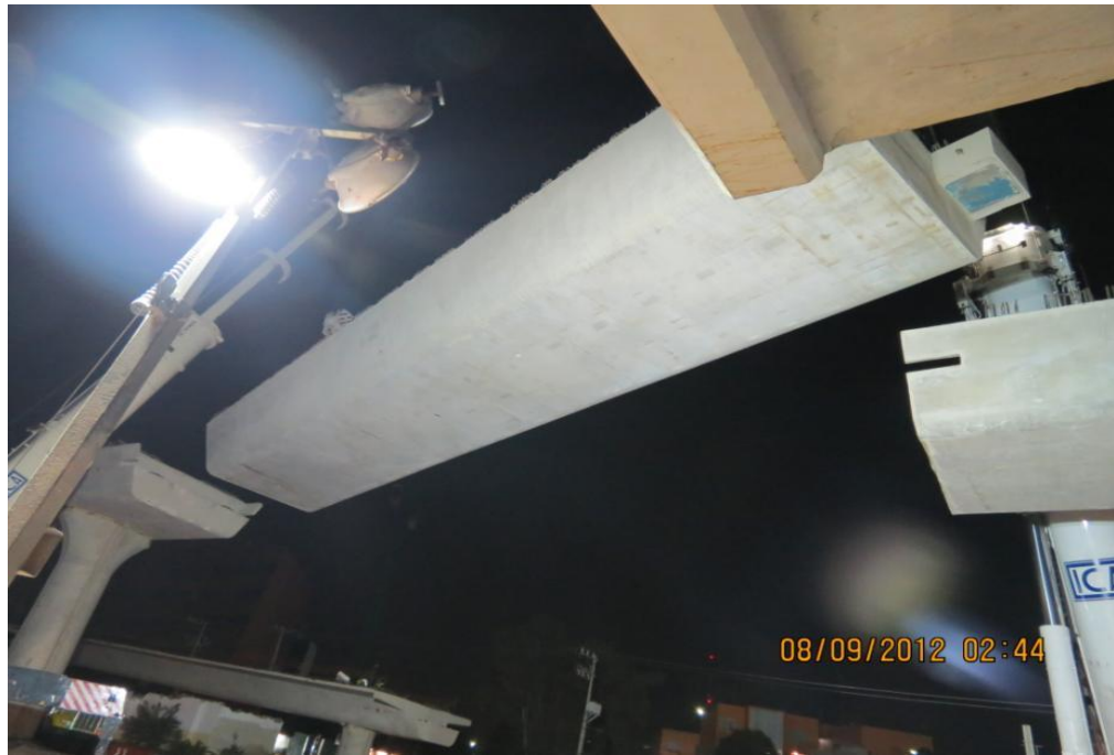
Ilustración 69. “Montaje de trabe de conexión”
