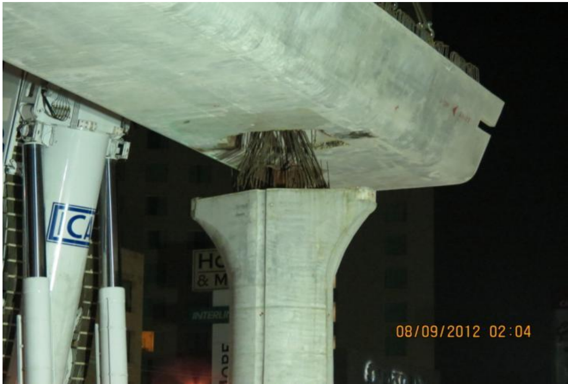
Ilustración 68. “Montaje de trabe en columna”
