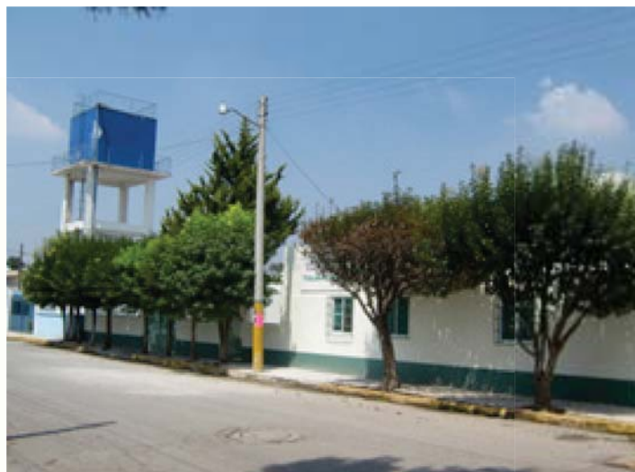
Los tanques elevados se localizan en múltiples puntos cercanos al terreno
