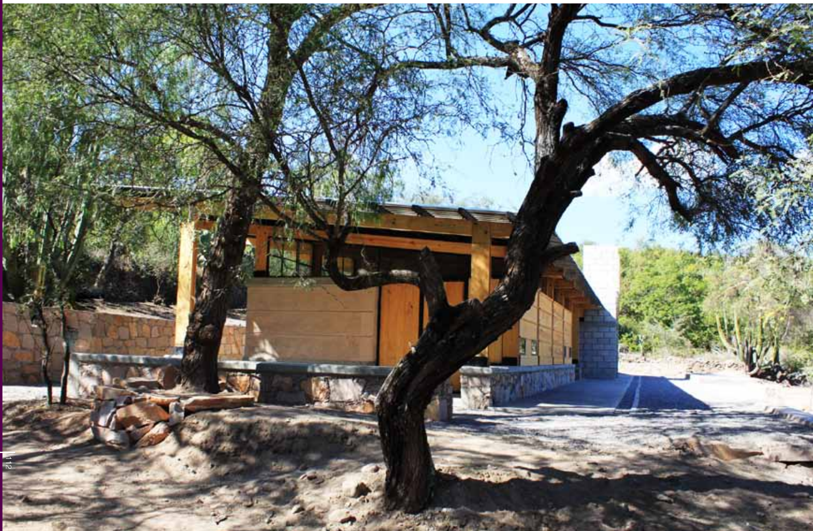
^ Fachada oriente / Vista desde el acceso principal
