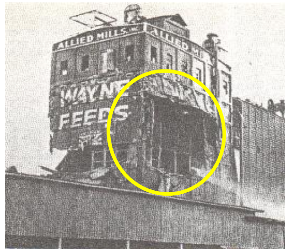
Fig. 3.7 Explosión en silo para harinas en Memphis, Tennessee (USA). Tomado de Ref. 5 “Silos”
