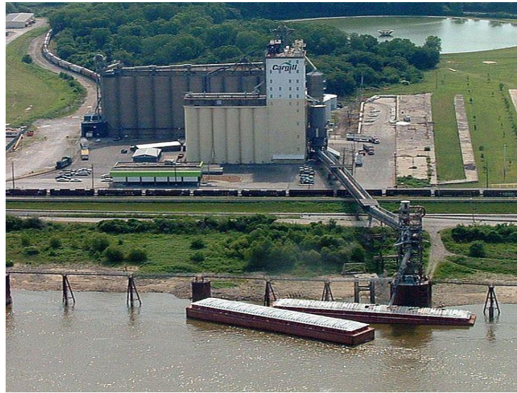
Fig. 2.1 Silo portuario al oeste de St. Louis, Illinois en la orilla del río Mississippi. Tomado de Ref. 24
