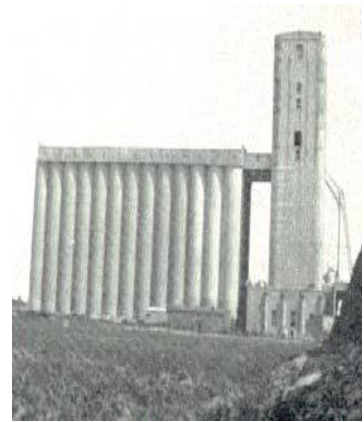
Fig. 6.1 Silos de Transcona, Canadá recién terminados en 1913
