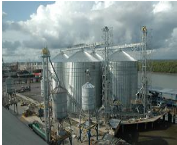
Fig. 2.7 Silo portuario moderno de acero corrugado y fondo plano
