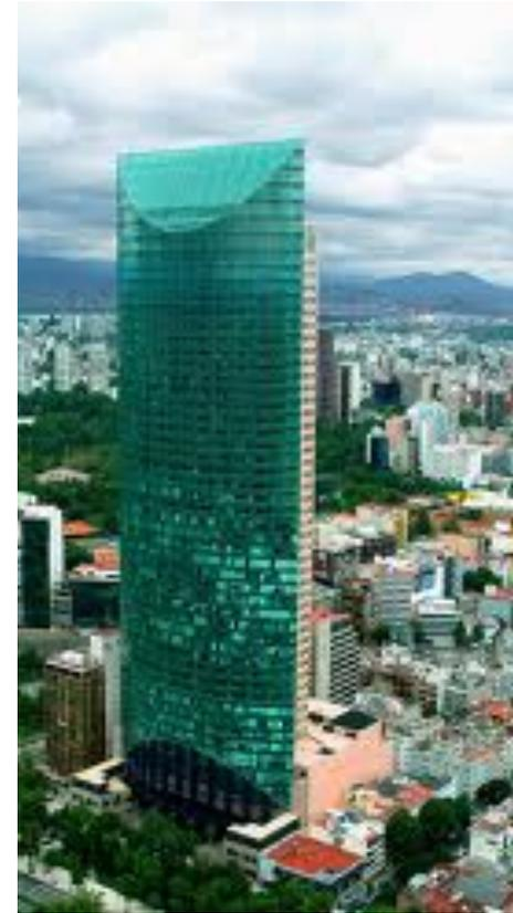
Cimentada con 252 pilotes a 40 metros de profundidad, estructura con 46.916 metros cúbicos de concreto, 21.200 toneladas de estructura metálica, 98 amortiguadores sísmicos. En 2009, un nuevo segmento con 9 pisos (uso mixto) se agrega a la derecha del complejo, mantiene el concepto original. El edificio más alto de México desde 2003, y el más alto de América Latina desde 2003 hasta 2010
