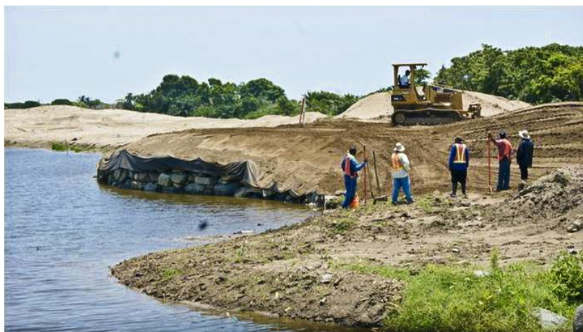
Foto. 4 Primeras obras para la cancha de Golf, relleno de humedal a finales del 2010 (Foto extraída del archivo de ENMUNEH)
