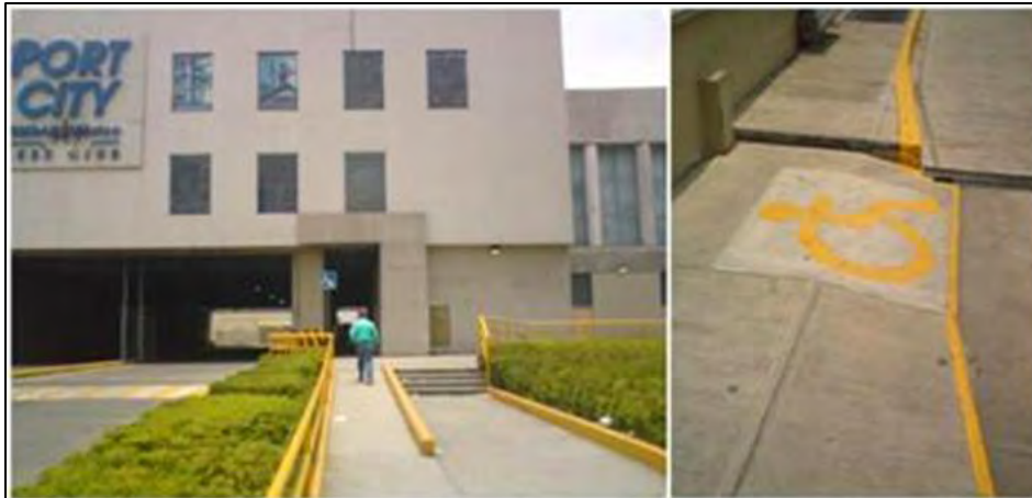
A la derecha rampa de entrada a CETRAM y a la izquierda, rampa que no permite la circulación de sillas de ruedas. Fuente: Salvador Medina Ramírez.
