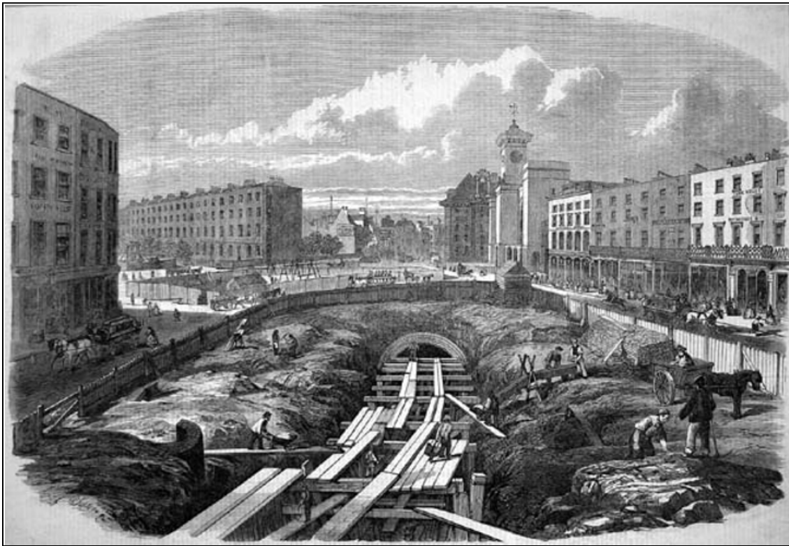
Construcción del metro de Londres mediante el método de falso túnel. Fuente: Museo del Transporte de Londres < www.ltmuseum.co.uk >
