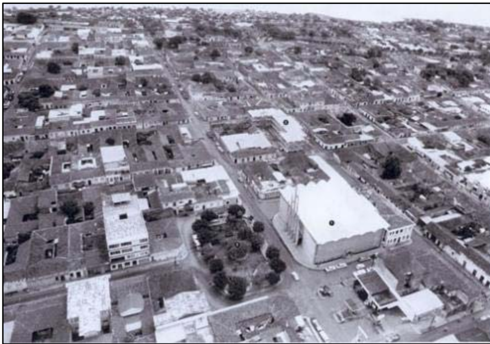
-Imagen 13-Iglesia de Santo Domingo y tipología típica de los barrios centrales de la ciudad antes del terremoto de 197. Al fondo el lago de Managua (Xolotlán)
