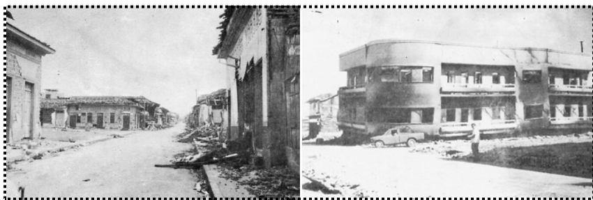
-Imagen 22- Mucha arquitectura habitacional, construida con variedad de materiales, fueron parcial o totalmente destruidas por el sismo de 1972 .10,000 fallecidos.
