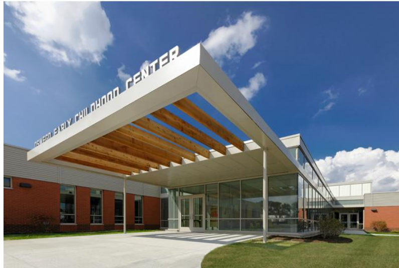
Fachada de acceso principal al centro
