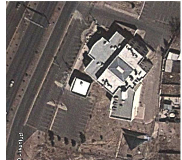
Vista aérea de la composición volumétrica y de conjunto del instituto
