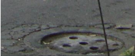
Coladeras existentes en las vialidades colindantes
