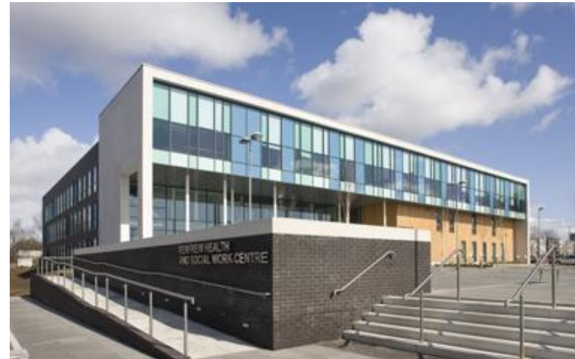
Vista general del edificio, desde su acceso e integración exterior
