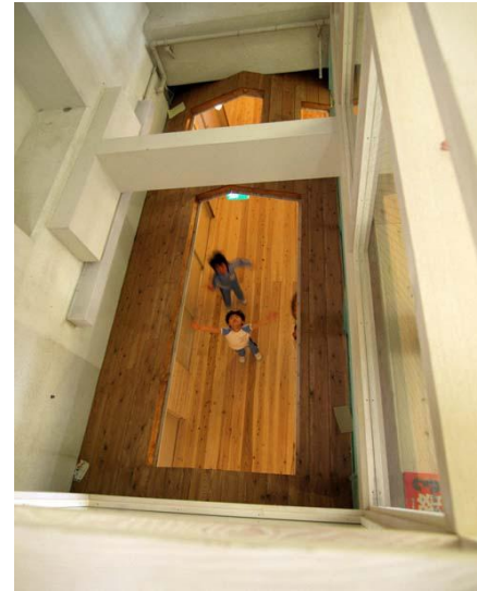
Variedad de vanos interiores tanto en muro como en cubierta para integrar la iluminación.
