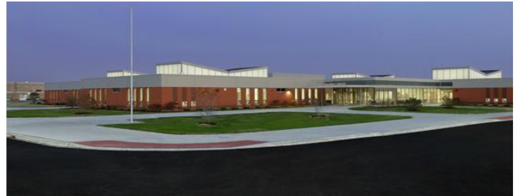
Vista panorámica del conjunto
