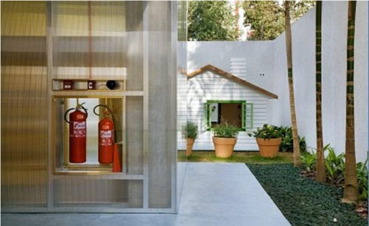
Vista interior de área común
