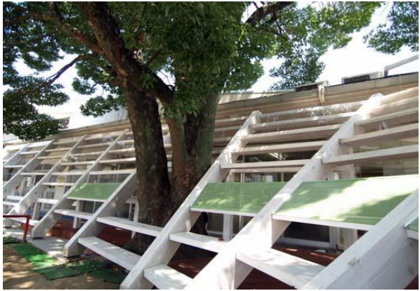
Diseño de grandes escaleras como muro, que sube a techo. La entrada de luz solar permite que entre a través de los vanos al interior del edificio.
