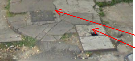
Registros para agua potable Registros para electricidad
